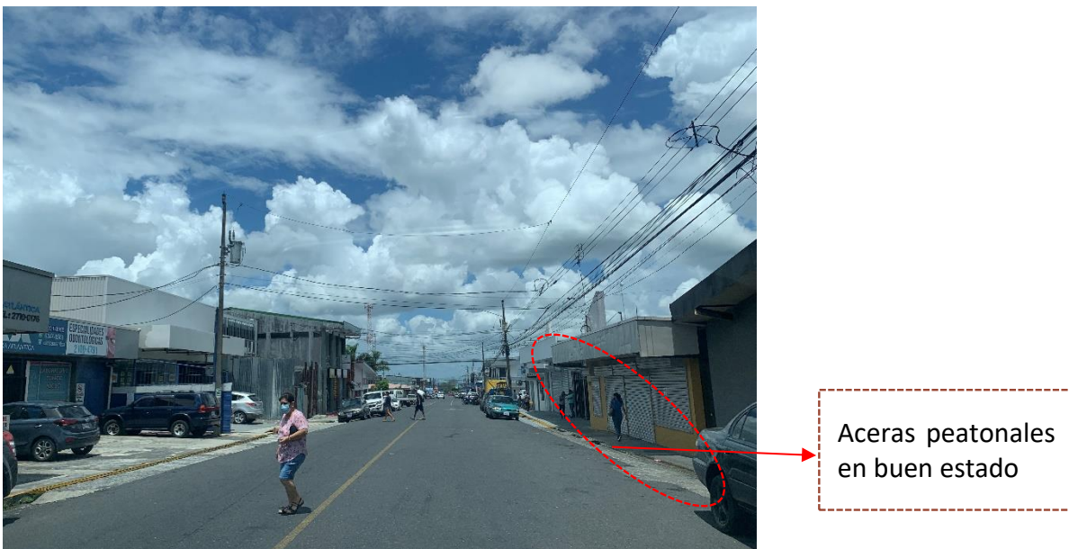
Figura 39 Calle 2 tramo avenida 0 - avenida 3
