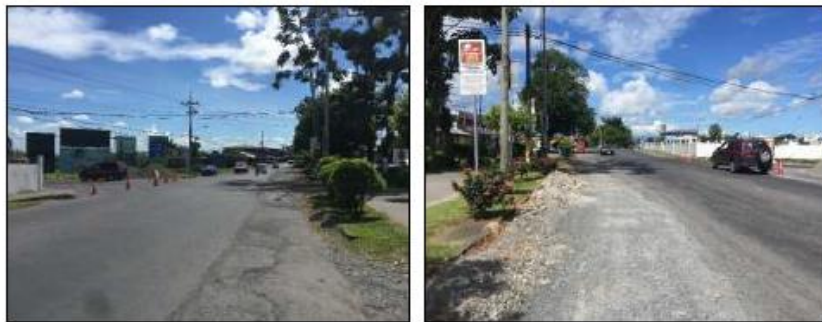
Figura 4. Intersección este. Foto 1. Acceso oeste. Foto 2. Acceso norte y este.
