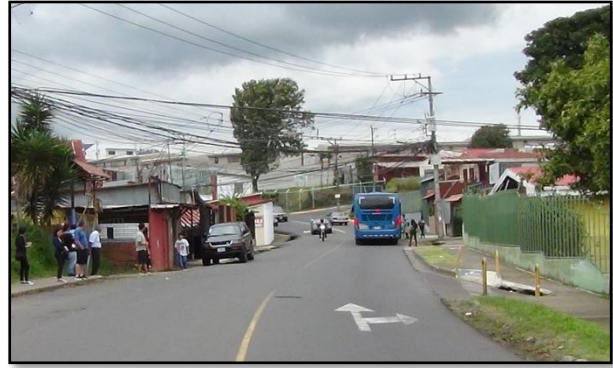
Figura. 5 Condiciones de visibilidad y estado del señalamiento vial, Ruta de Travesía N°10802, Purral Goicoechea, vista sentido Oeste-Este.
