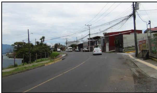
Figura. 2 Condiciones de visibilidad y estado del señalamiento vial, Ruta de Travesía N°10802, Purral Goicoechea, vista sentido Este a Oeste.
