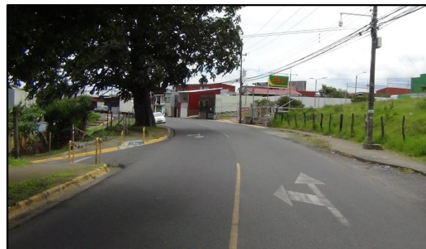
Figura. 3 Condiciones de visibilidad y estado del señalamiento vial, Ruta de Travesía N°10802, Purral Goicoechea, vista sentido Este a Oeste.
