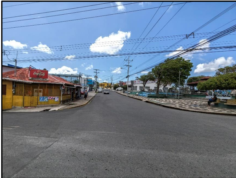
Imagen N° 2. Carpeta asfáltica Ruta Nacional N° 935.
