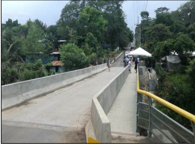
Figura N° 5 Imagen ilustrativa de la Pasarela Peatonal
