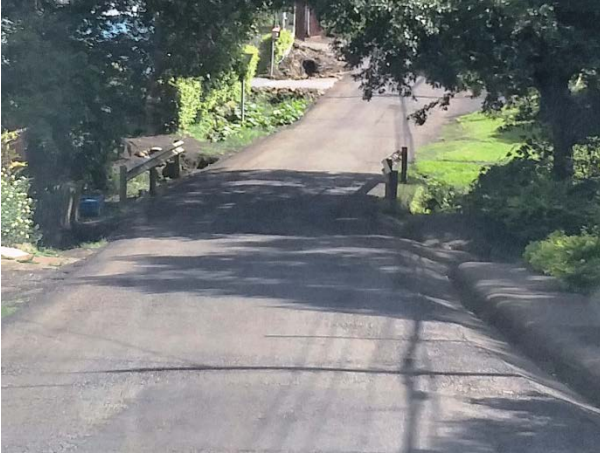
Figura N° 3 Puente Angosto existente, sentido sur – norte, aceras incompletas.
