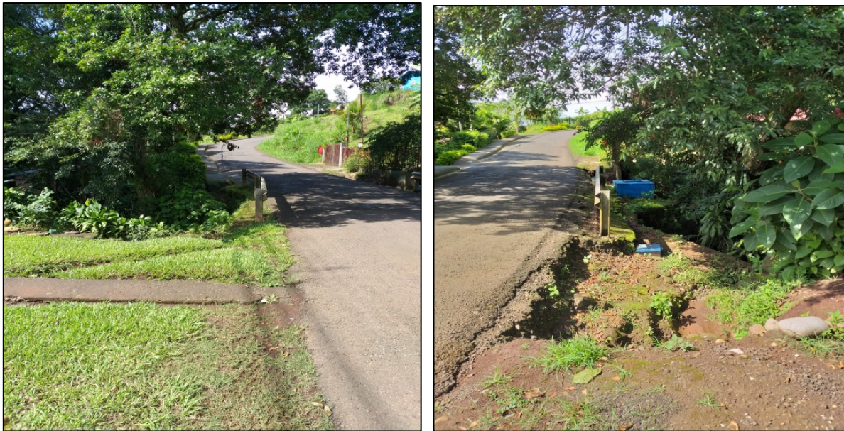
Figura N° 4 Costados del puente angosto, sin aceras o pasarelas peatonales.
