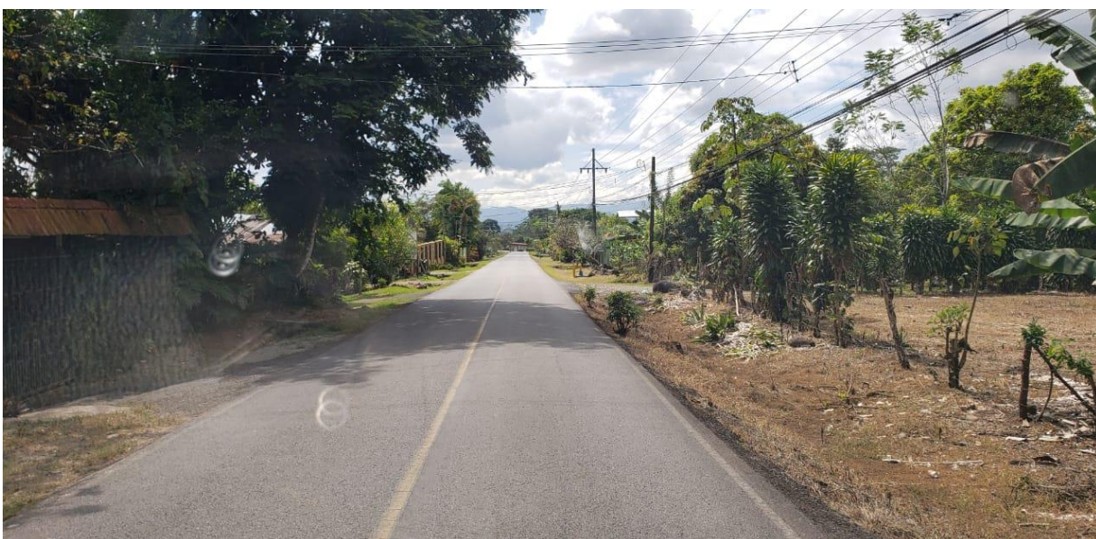
Figura 3. Tramo de zona de estudio, sentido hacia Rivas
