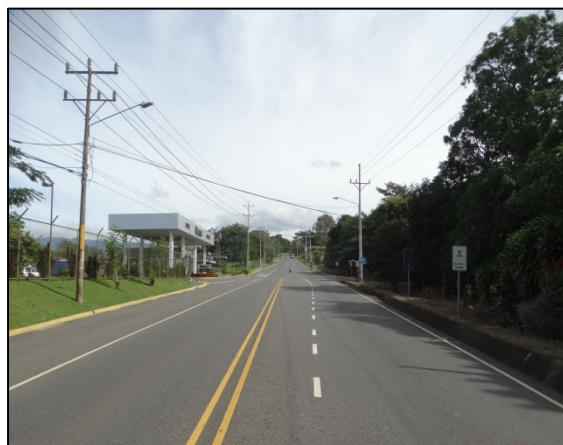
Figura 2. RN 154, señalización vial existente
