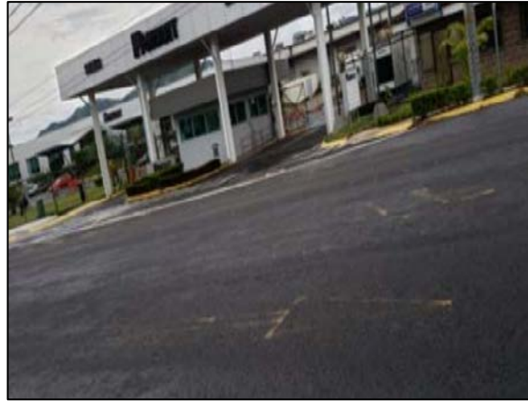
Figura 4. Carpeta frente a la Panduit sin grietas ni baches
