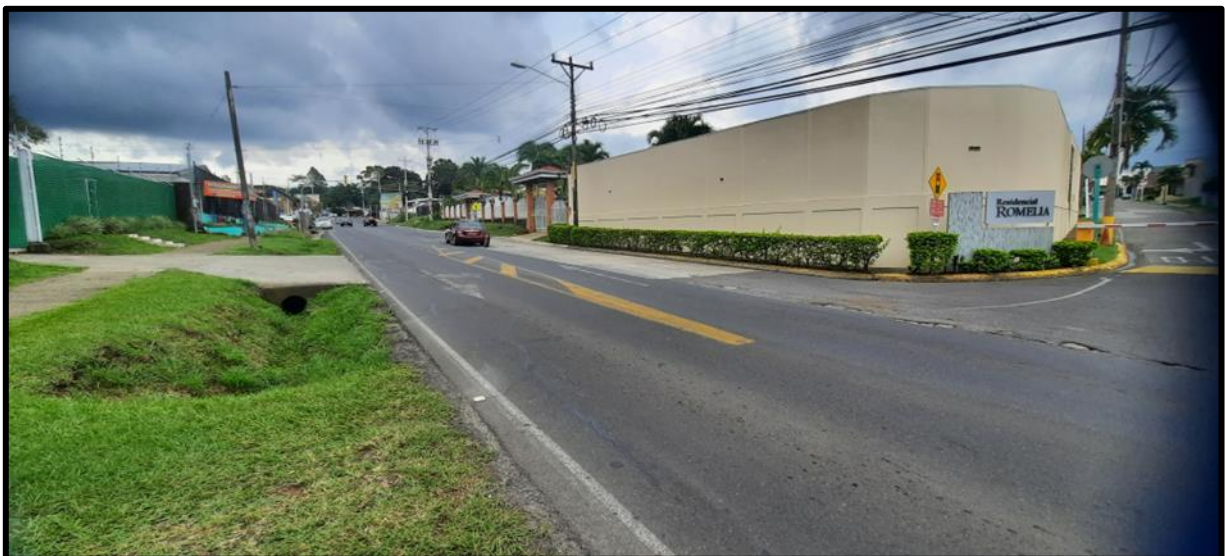
Figura 3 Vista norte ruta nacional N.º 130, Esc. Timoleón Morera Soto, San Isidro, Alajuela. Fuente: Propia.
