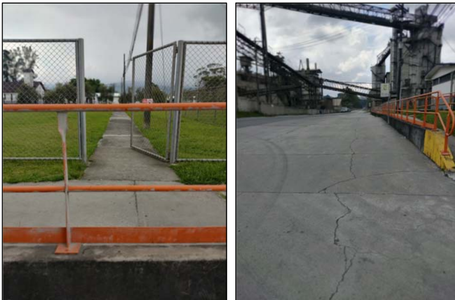
Imágenes 10 y 11 Calle de acceso a centro educativo con portón y prohibición de acceso.
