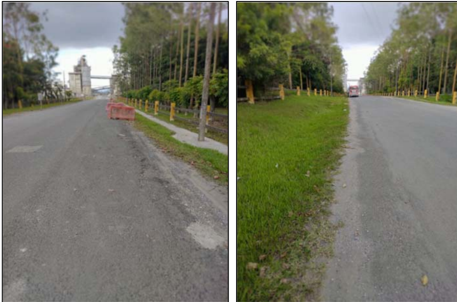
Imágenes 4 y 5 Vista de margen derecha e izquierda respectivamente desde el acceso oeste de la R. N. N° 231.
