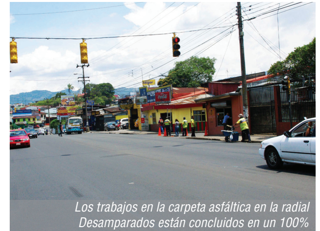
En la radial Paso Ancho, resta colocar demarcación
