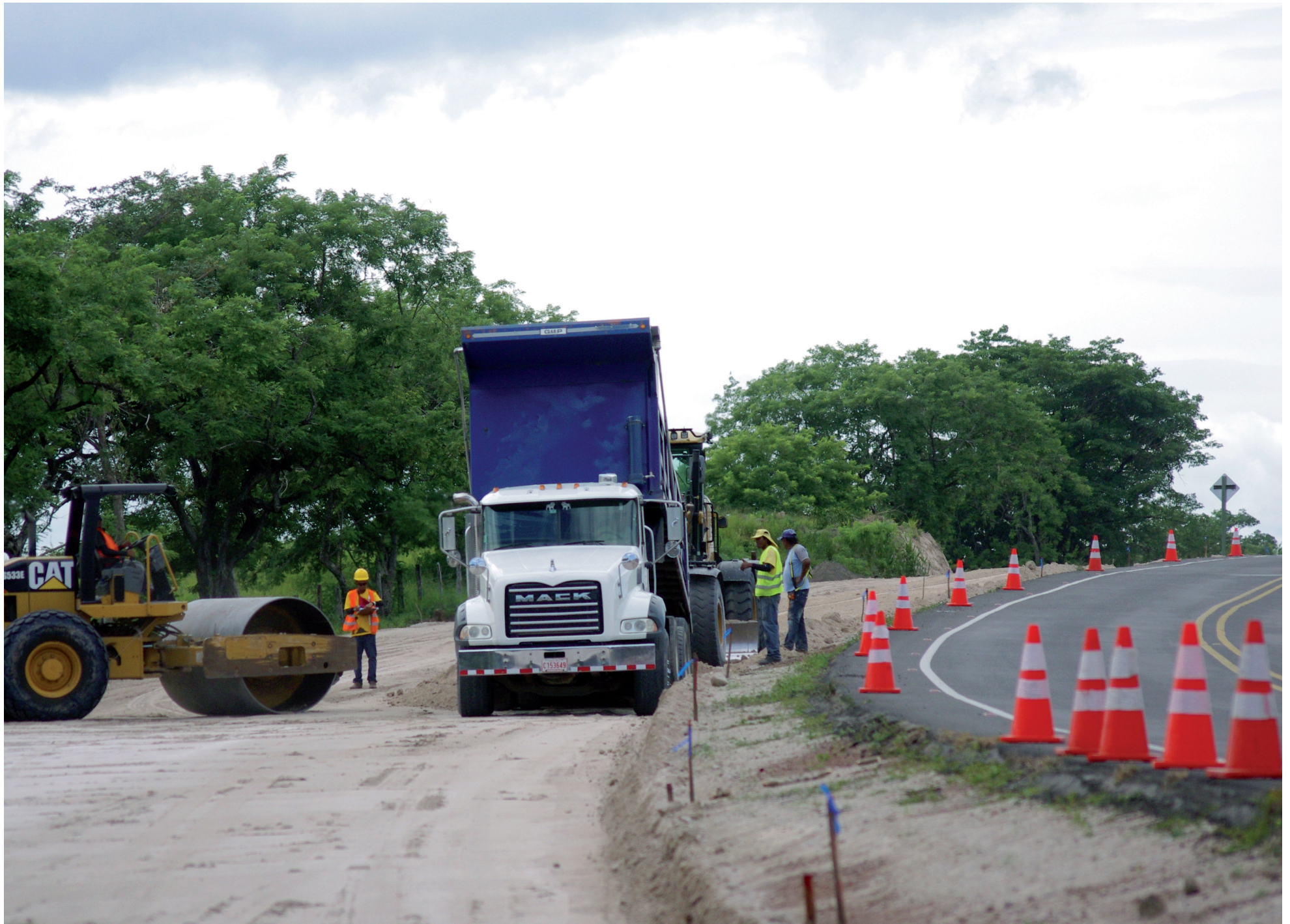
Trabajos de ampliación del tramo Cañas-Liberia de la ruta Interamericana Norte
