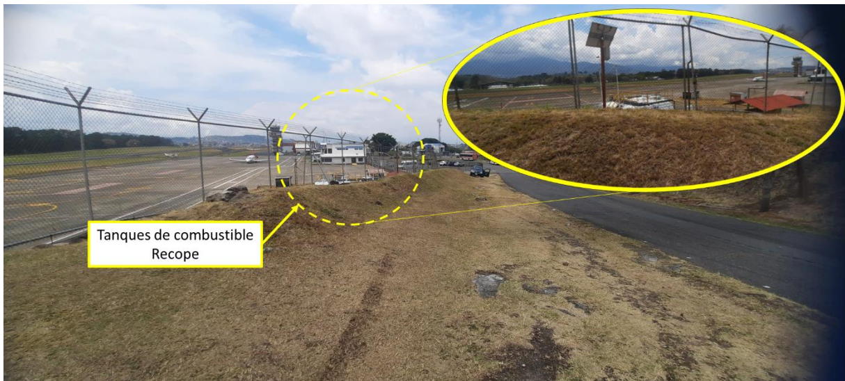
Figura 2 Ubicación de tanques de combustible Recope, Pavas, San José. Fuente: Propia.
