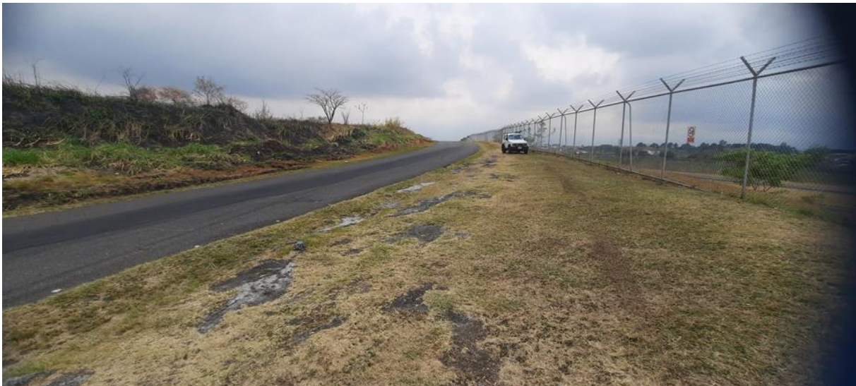
Figura 3 Curva al aproximarse a los tanques de combustible de Recope, en el aeropuerto Tobías Bolaños en Pavas, San José. Fuente: Propia.
