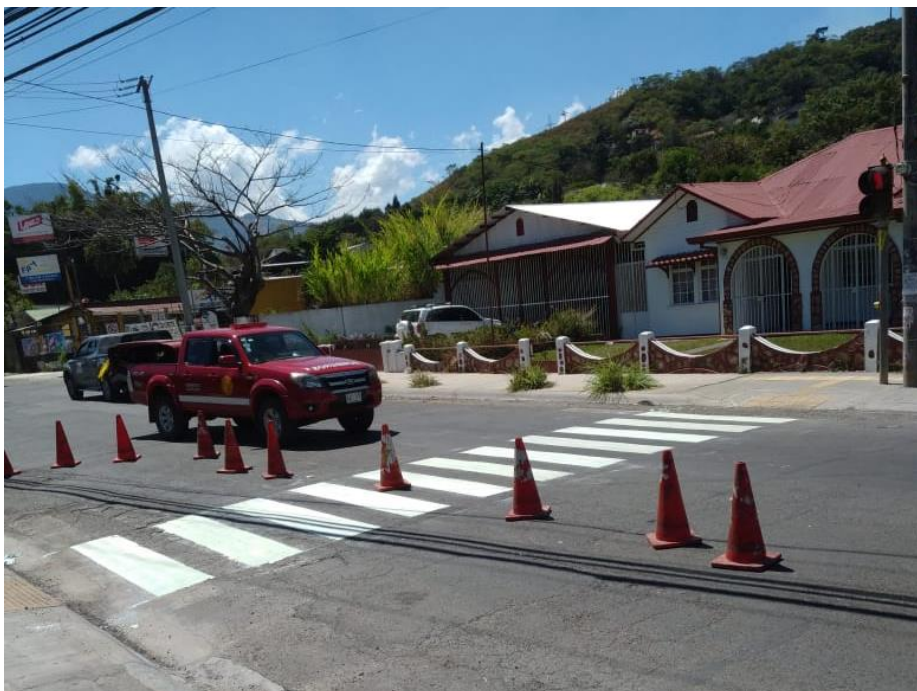
Figura 5. Paso Peatonal Escuela Juan Monge Guillen RN 212
