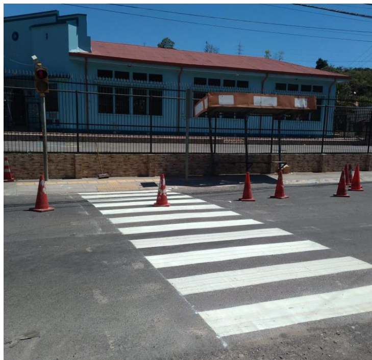
Figura 7. Paso Peatonal Escuela Juan Monge Guillen RN 212
