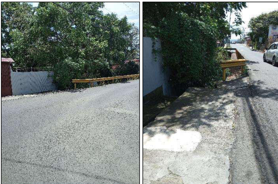
Imágenes 7 y 8. Terminales de las barreras del puente.
