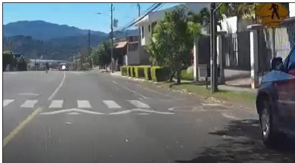
Figura 6. Demarcación de paso peatonal sin semáforo peatonal, Calle 93. Fuente. Elaboración propia, 2021.
