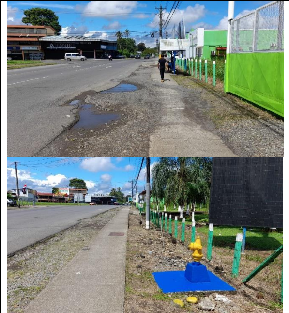
Figura 6. Acera y espaldón del costado norte del acceso “este”
