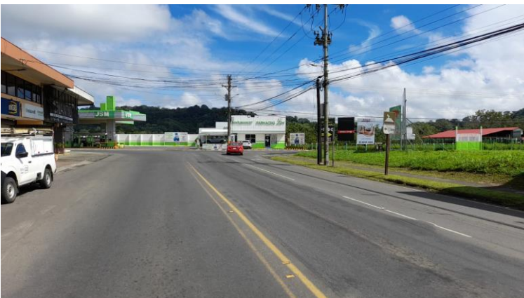
Figura 7. Acceso “sur” de la intersección de Ruta Nacional N° 4 y 505 en Puerto Viejo de Sarapiquí
