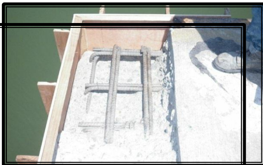
Reparación estructural muelle cruceros
