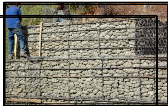
Muro de gaviones
