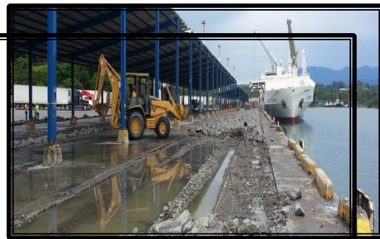
Reparación estructural muelle Moín
