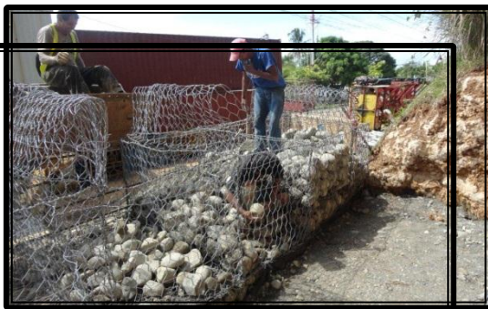
Muro de gaviones
