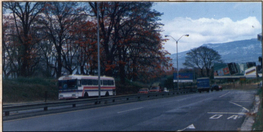
Autopista General Cañas Próxima a concesionarse
