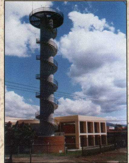
Edificio de control de tráfico aéreo
