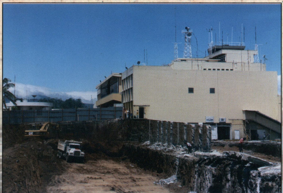
Nuevos Trabajos en el aeropuerto Juan Santamaría
