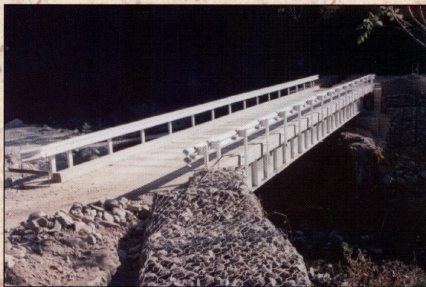
Puente Buena Vista, Rivas de Pérez Zeledón
