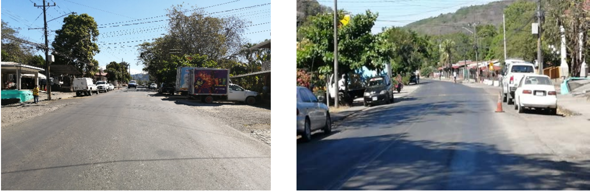
Figura N° 5. Reductor de velocidad sobre Ruta Nacional N° 145, frente a Delegación Policial de Las Juntas
