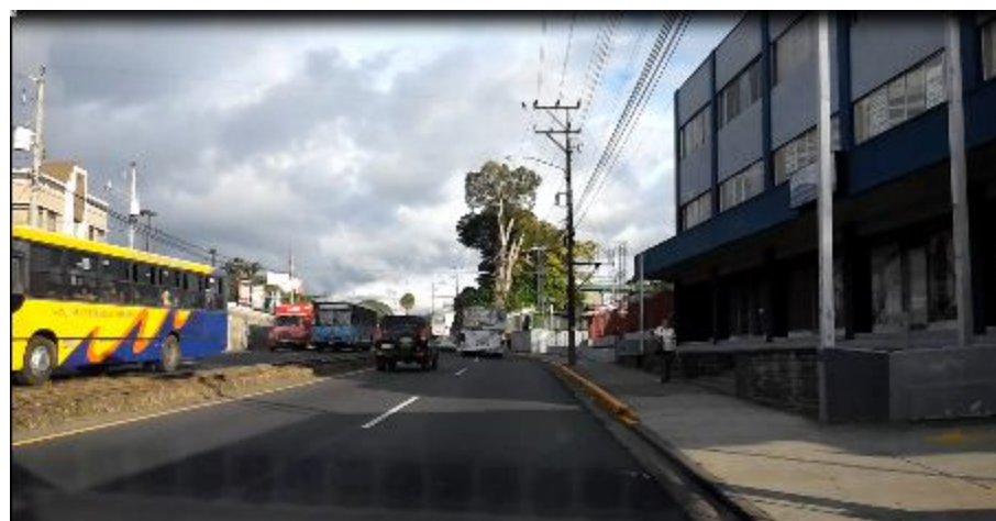
Foto 48. Línea férrea Avenida Central en el tramo Universidad Americana y Calle 35
