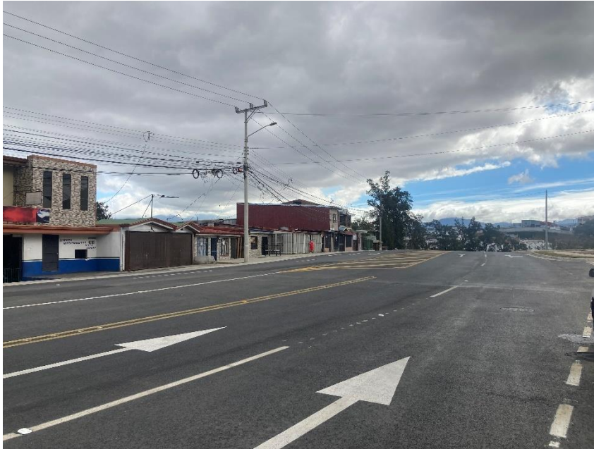
Figura 6. Demarcación horizontal. Fuente: Propia, 2022.
