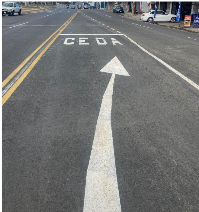
Figura 7. Demarcación horizontal. Fuente: Propia, 2022.
