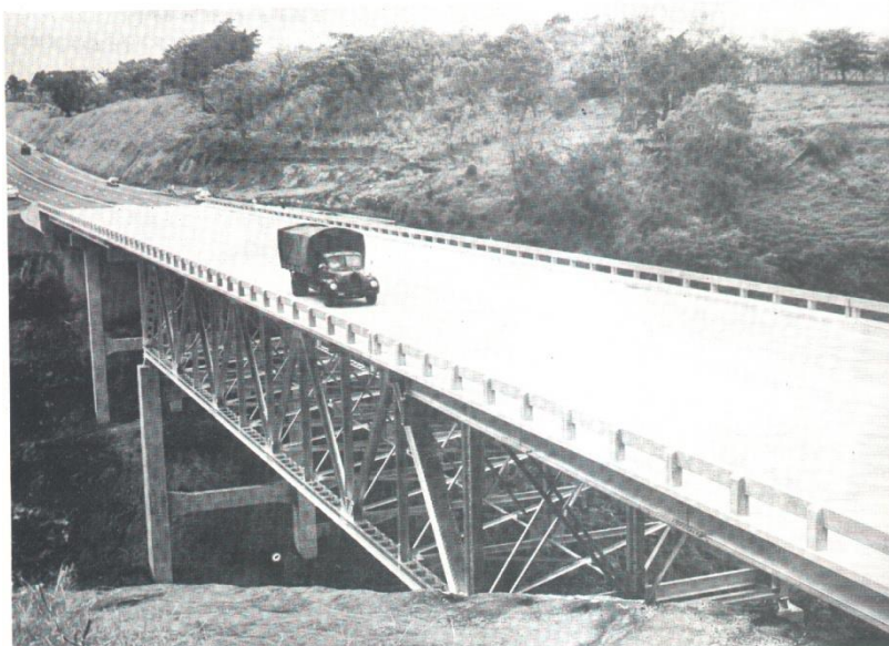
PUENTE SOBRE EL RIO VIRILLA. AUTOPISTA EL COCO
