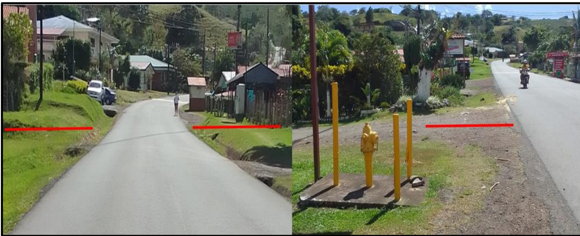
Imagen N° 3. Falta de aceras (línea roja).
