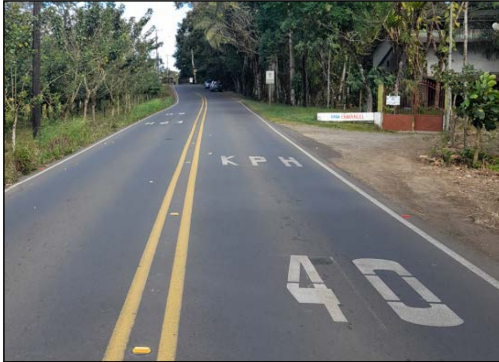
Figura 11. Demarcación de velocidad con 40 KPH en el ingreso al puente Río Fortuna sentido El Tanque-Los Ángeles
