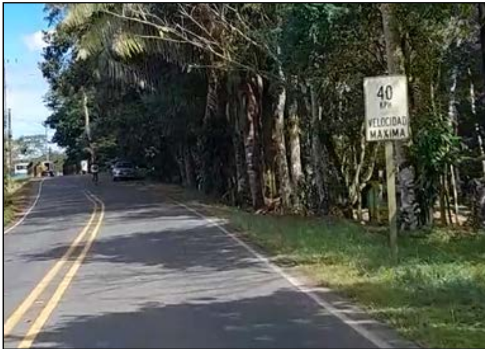
Figura 7. Señal de velocidad 40 KPH VELOCIDAD MÁXIMA en sentido El Tanque - Los Ángeles
