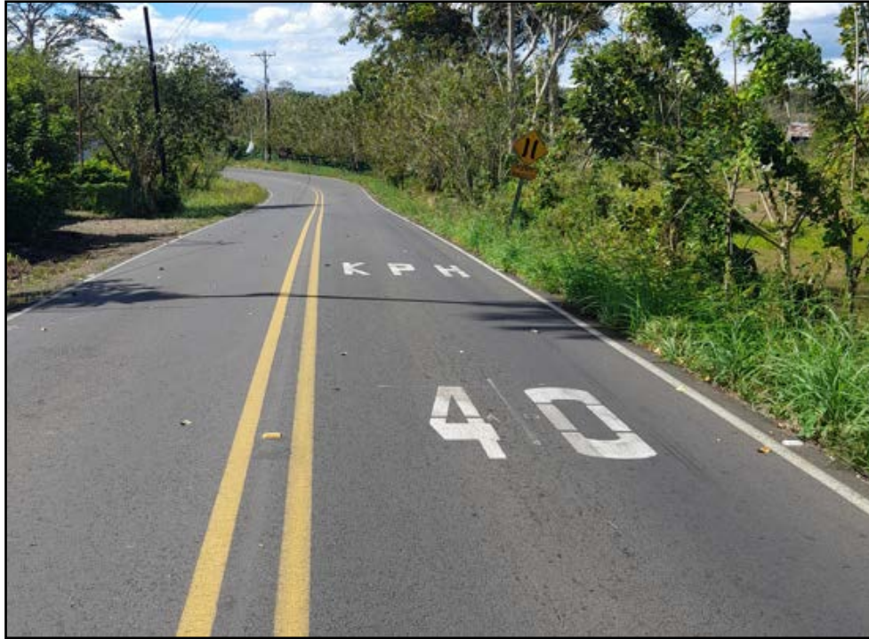
Figura 9. Demarcación de velocidad con 40 KPH en el ingreso al puente Río Fortuna sentido Los Ángeles-El Tanque
