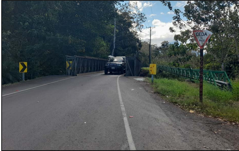
Figura 6. Señales tipo CHEVRON y señal de CEDA EL PASO en sentido Los Ángeles – El Tanque
