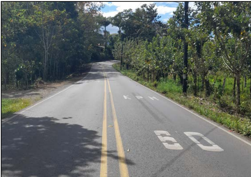
Figura 10. Demarcación de velocidad con 60 KPH en la salida al puente Río Fortuna sentido Los Ángeles-El Tanque
