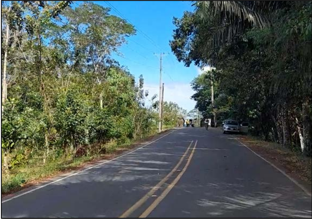
Figura 3. Zona de estudio, sentido El Tanque – Los Ángeles
