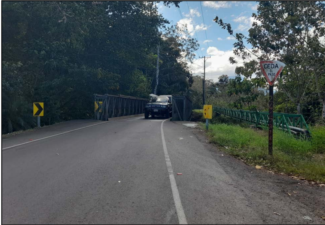
Figura 2. Zona de estudio, sentido Los Ángeles – El Tanque
