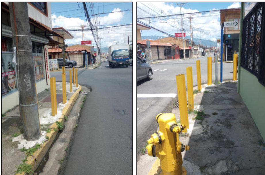
Imágenes 6 y 7 Postes en esquinas lado este.
