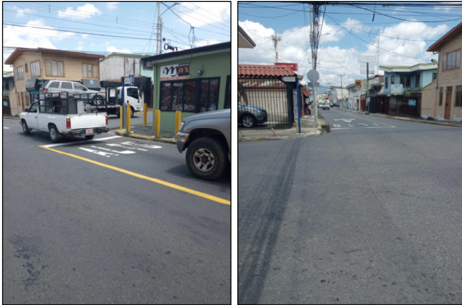
Imágenes 4 y 5. Vista del acceso este y oeste de la avenida 27.
