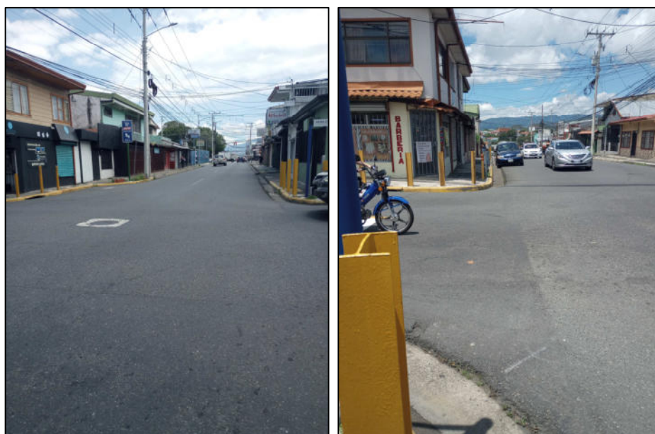
Imágenes 2 y 3. Vista del acceso norte y sur de la Ruta Nacional N° 201.
