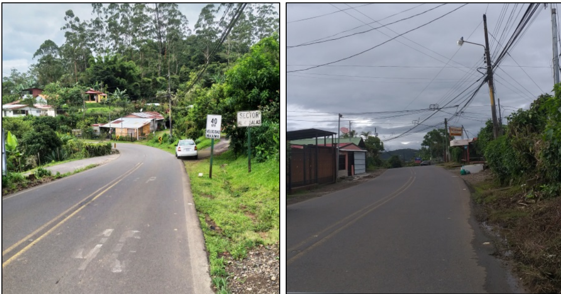
Figura N° 4 Señal de 40 kph 200 norte de la intersección borrosa, líneas de centro y rótulos borrosos.
