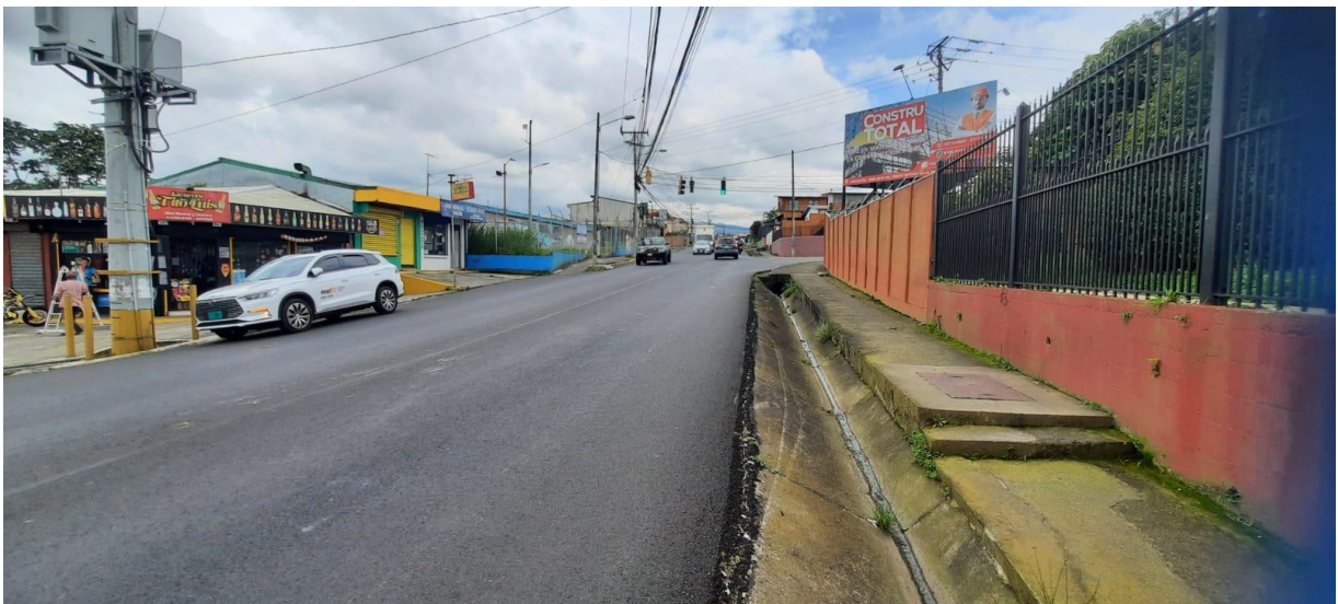
Figura 2 Vista oeste intersección RN N. ° 205-Calle Carmen, Mata Plátano, Goicoechea, San José. Fuente: Propia.
