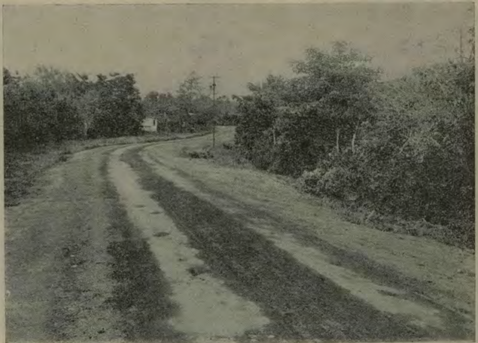
La calle de «Los Siles» en Lourdes de Montes de Oca, ha sido objeto de un completo arreglo.
