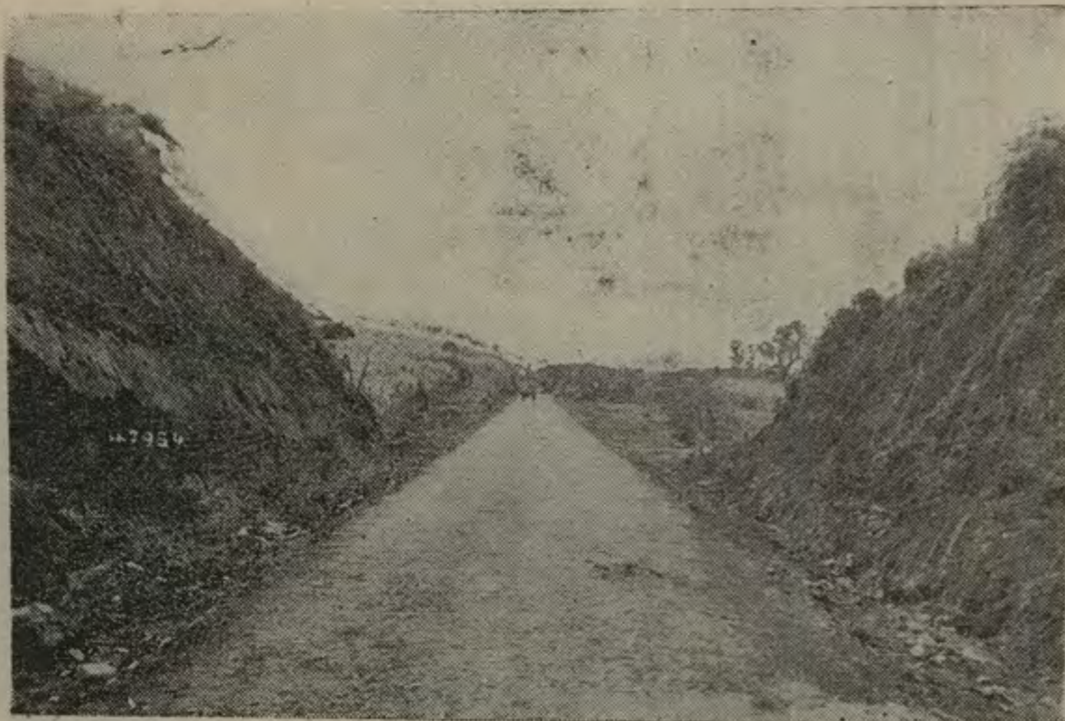
Una gráfica de la carretera a Villa Quesada (cantón de San Carlos), con pavimento de asfalto frío.
