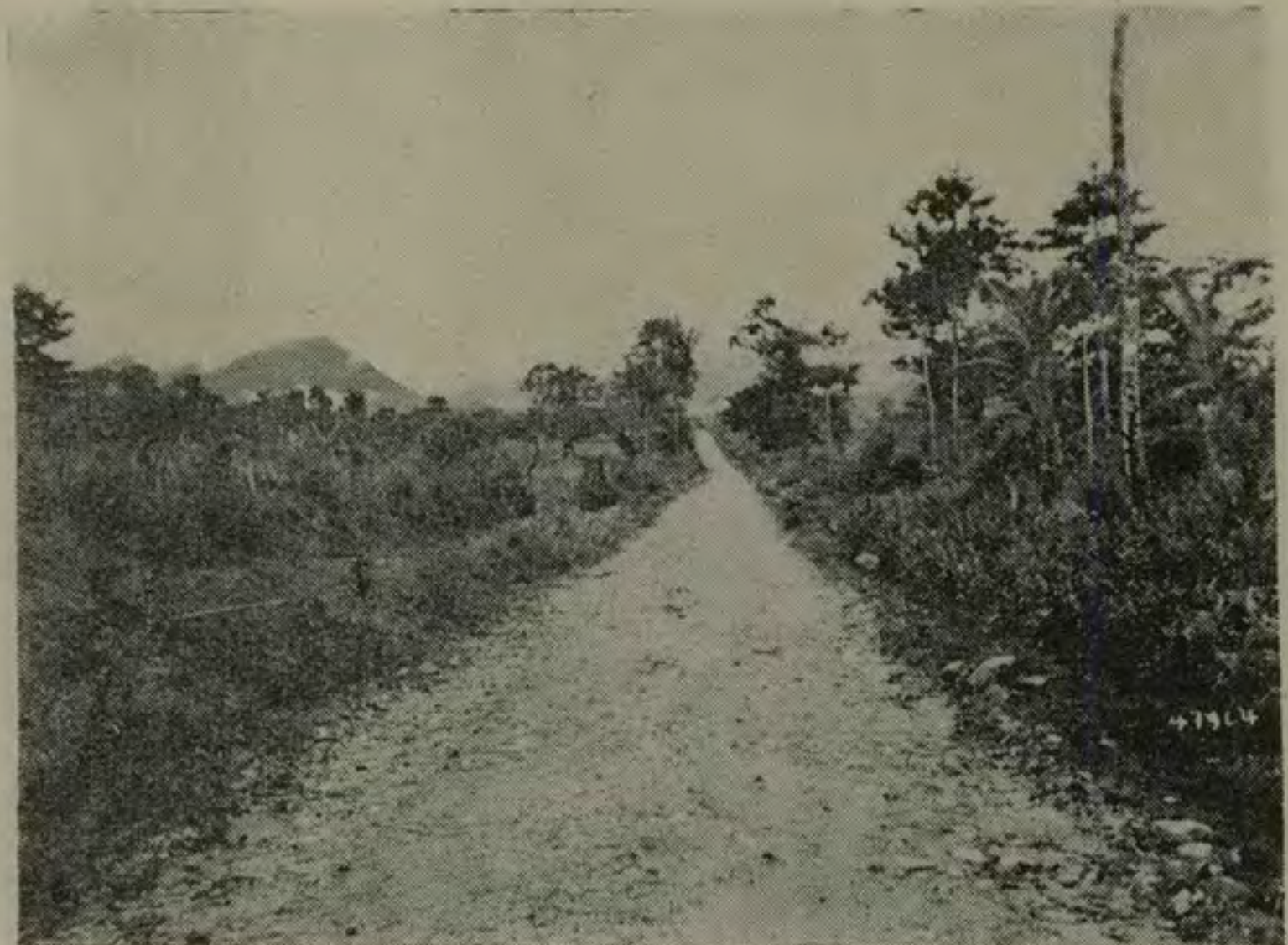
Carretera Aguas Zarcas-Pital (cantón de San Carlos.)
