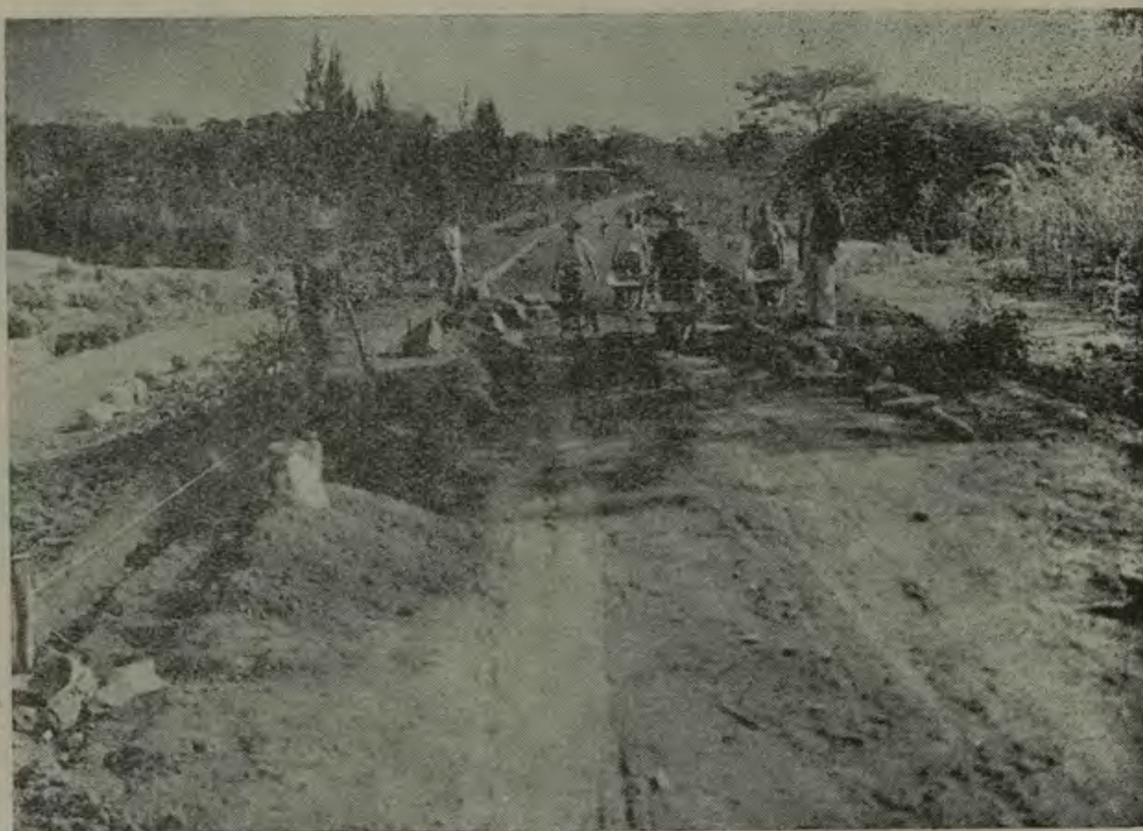
A los costados del puente sobre el río María Aguilar, entre San Francisco de Dos Ríos y El Zapote, se han hecho rellenos adecuados.
