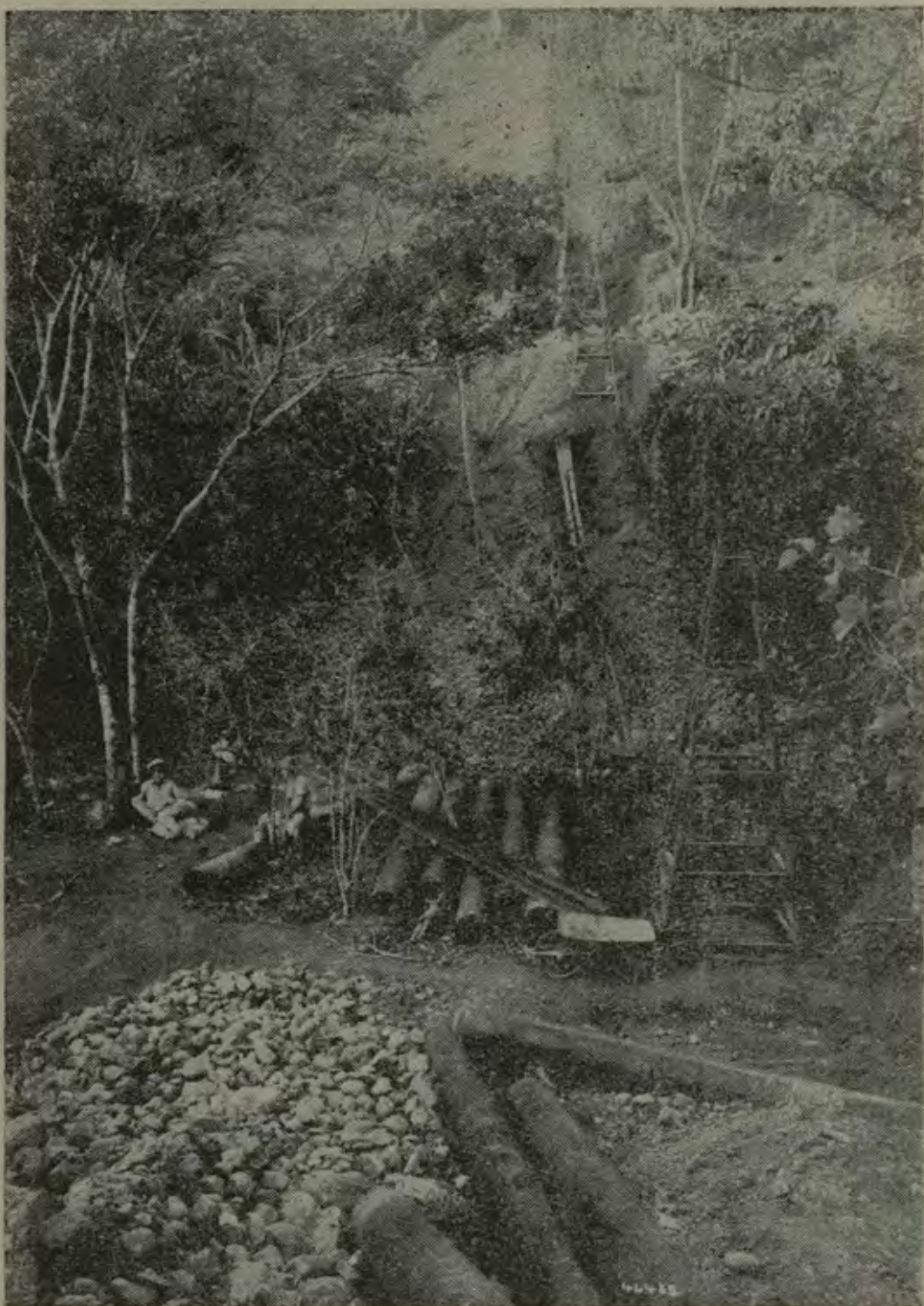
Muestra el grabado los trabajos ya muy adelantados de la cañería del cantón de Moravia.
