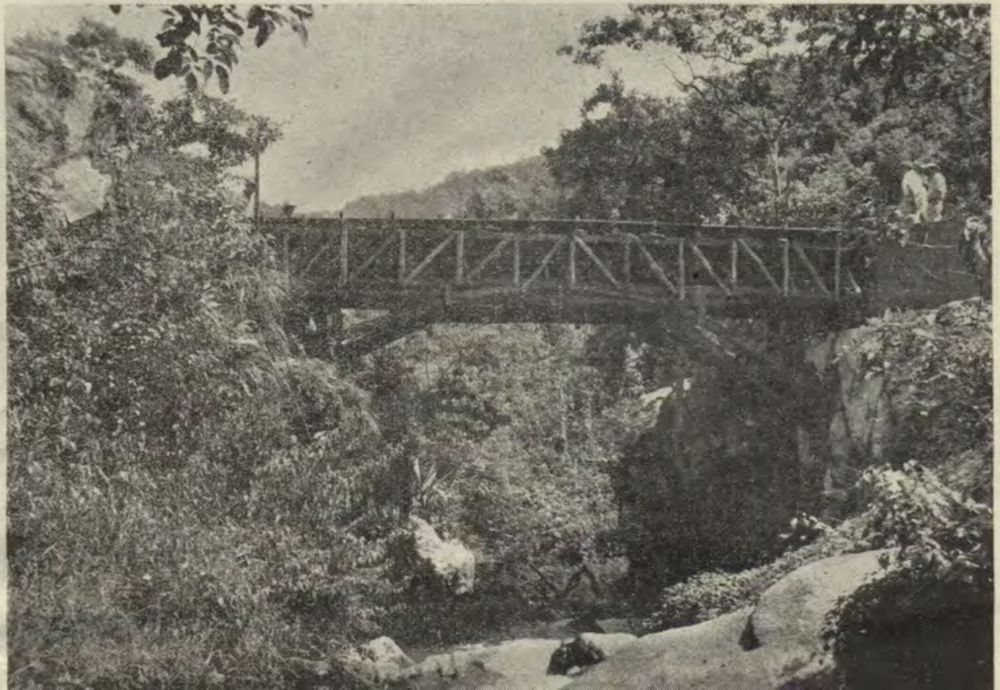
Puente en construcción en San Andrés de Tarrazú.
