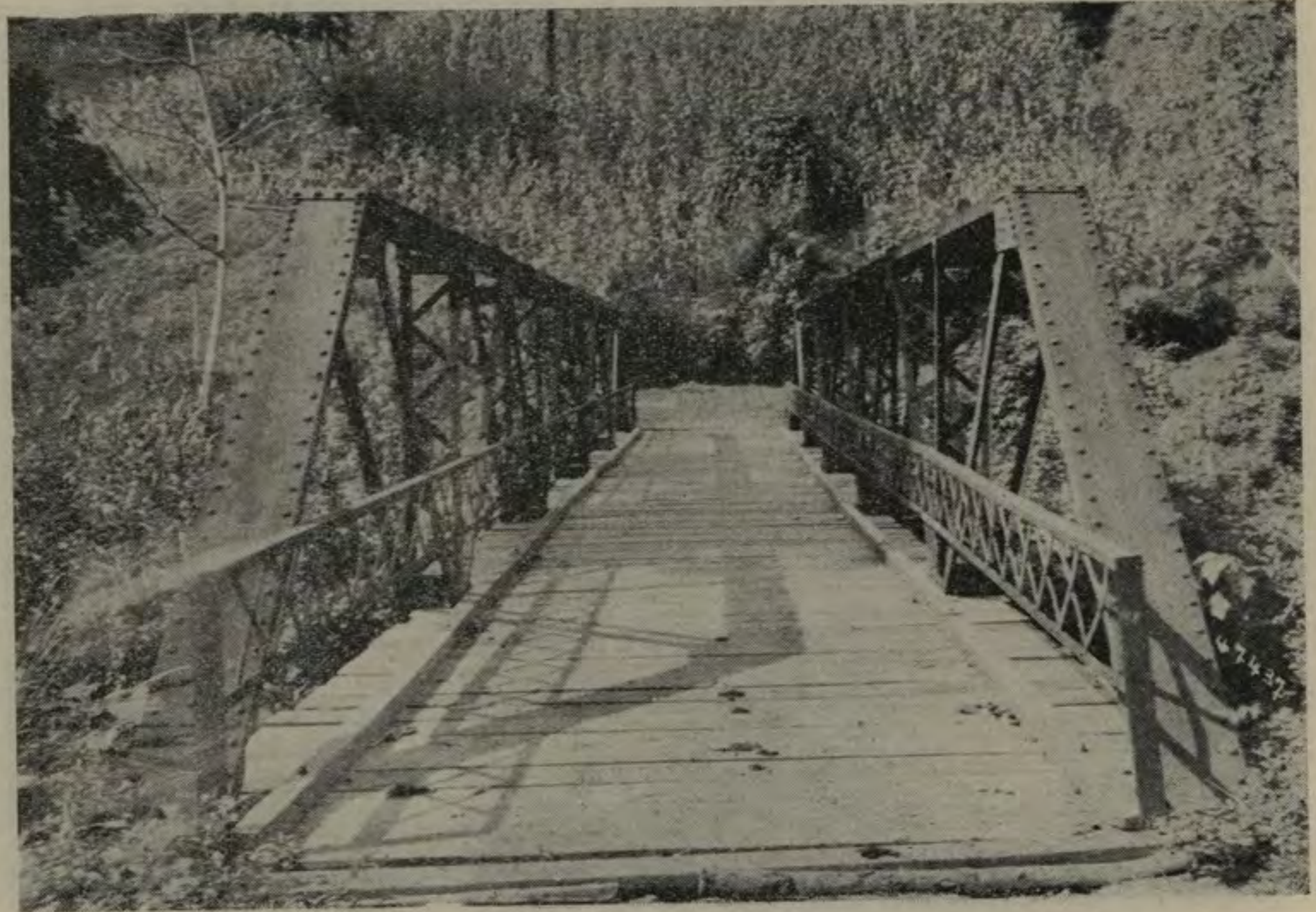
Puente reconstruído sobre el río Jaris entre Turrúcares y Puriscal,
