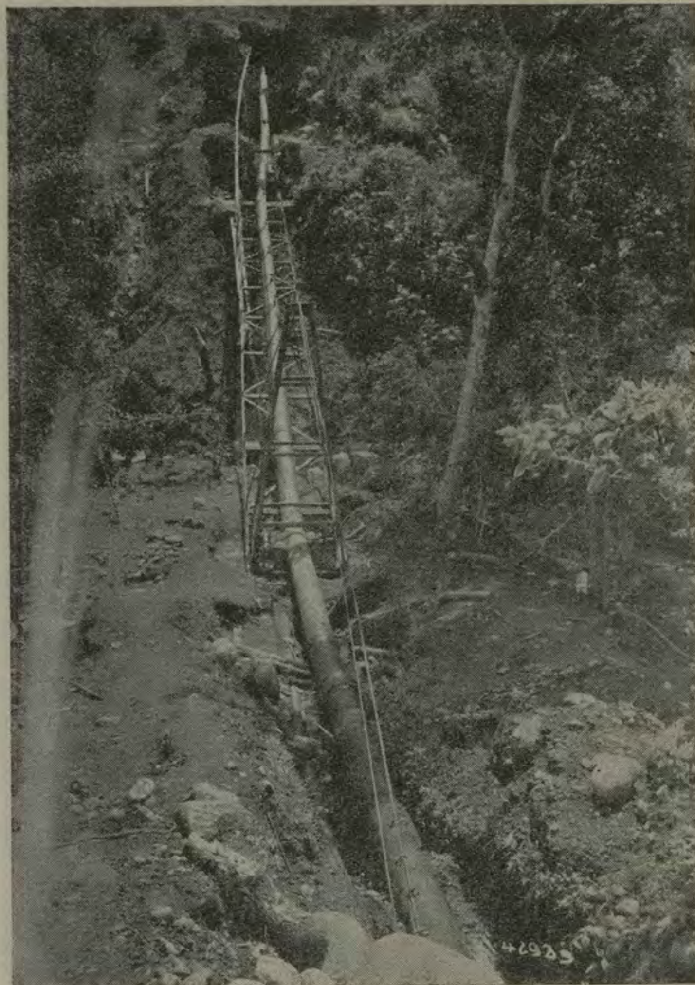
Otra vista de los trabajos realizados para dotar a los vecinos de Moravia y de sus alrededores, de agua potable.
