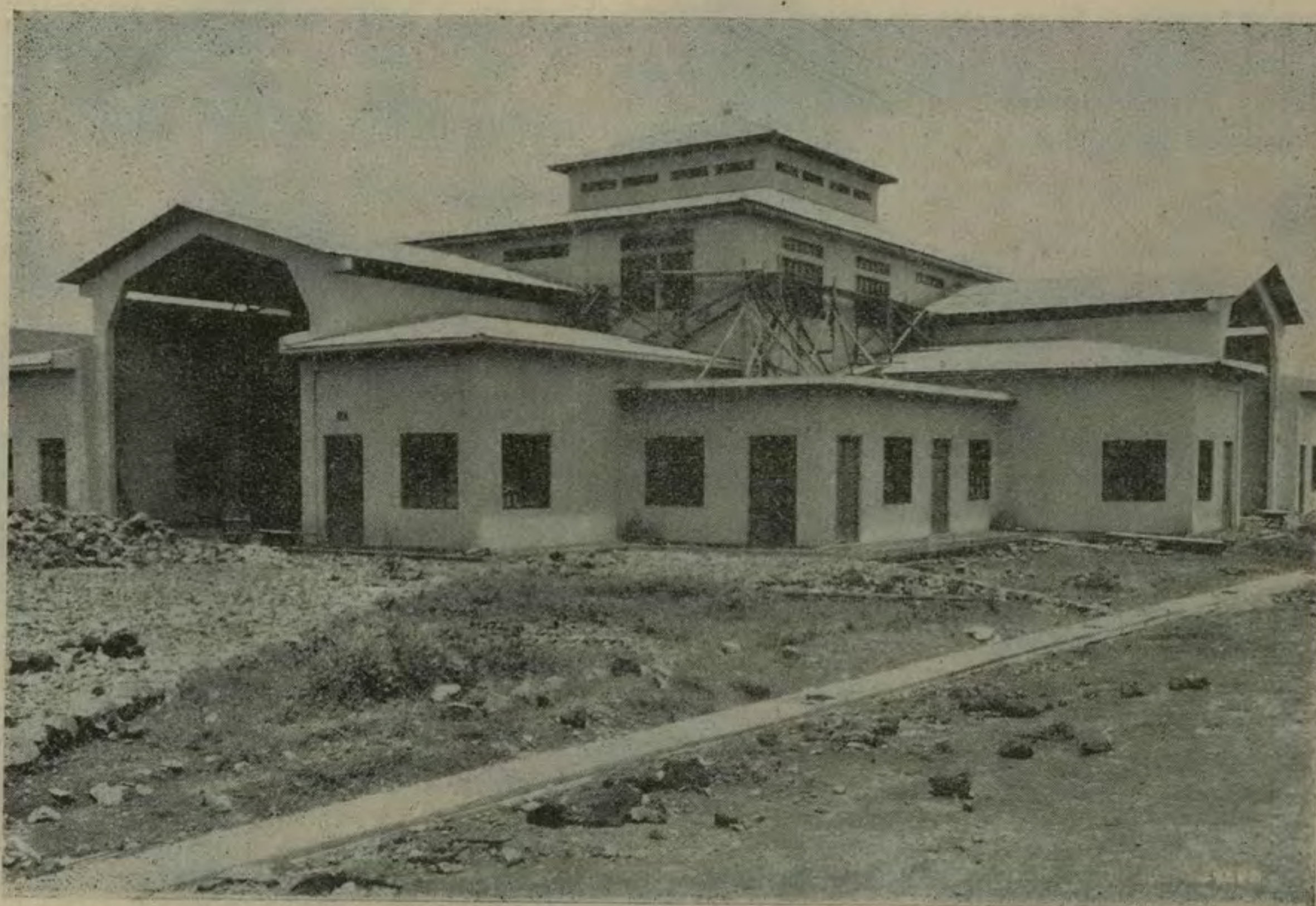
Mercado de la ciudad de San Ramón, que está al concluirse.
