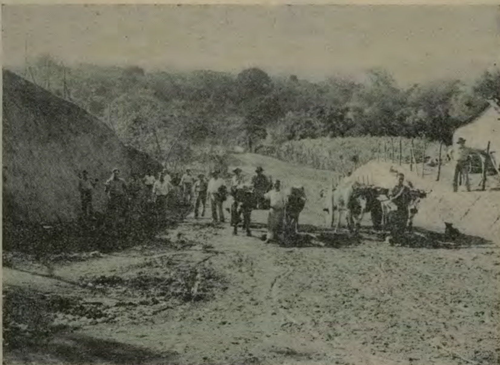
Baches profundos imposibilitaban casi el tránsito en el paso de «Las Montoya», camino al Zapote. Gracias al magnífico trabajo ahí ejecutado, terminaron esas dificultades en beneficio de la agricultura local.
