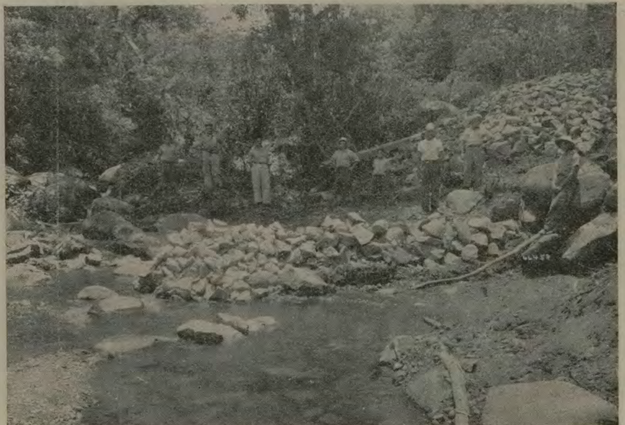
Trabajos en la presa para la cañería de San Juan de Dios de Desamparados.
