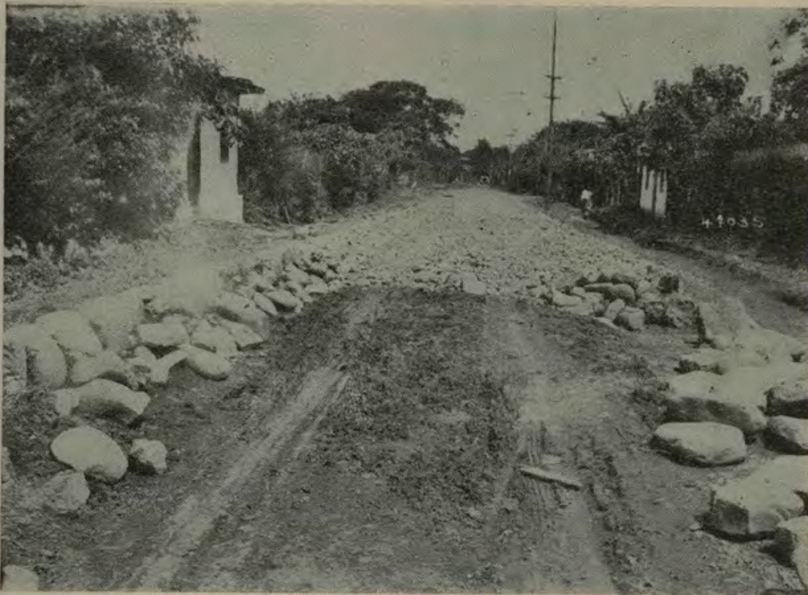
Con todo empeño se ha arreglado esta calle del distrito «Calle de Blancos» en el cantón de Goicoechea.
