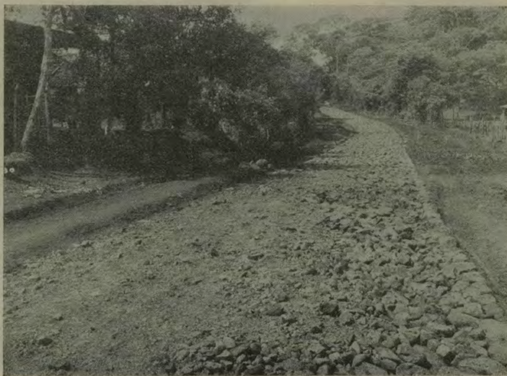
Carretera construida en Mer- cedes Sur de Puriscal.
