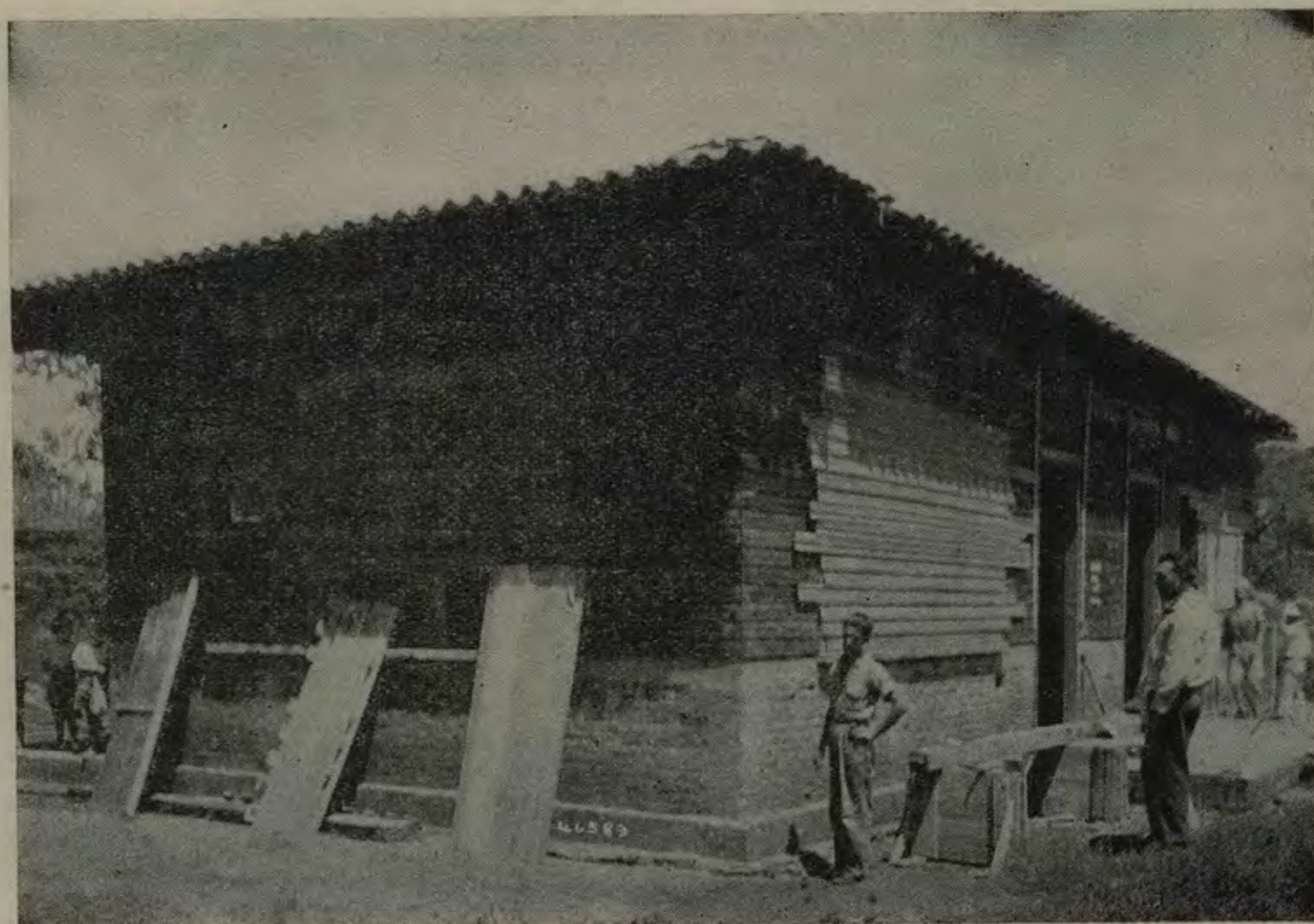
Escuela en construcción en el distrito de Tacares de Grecia.
