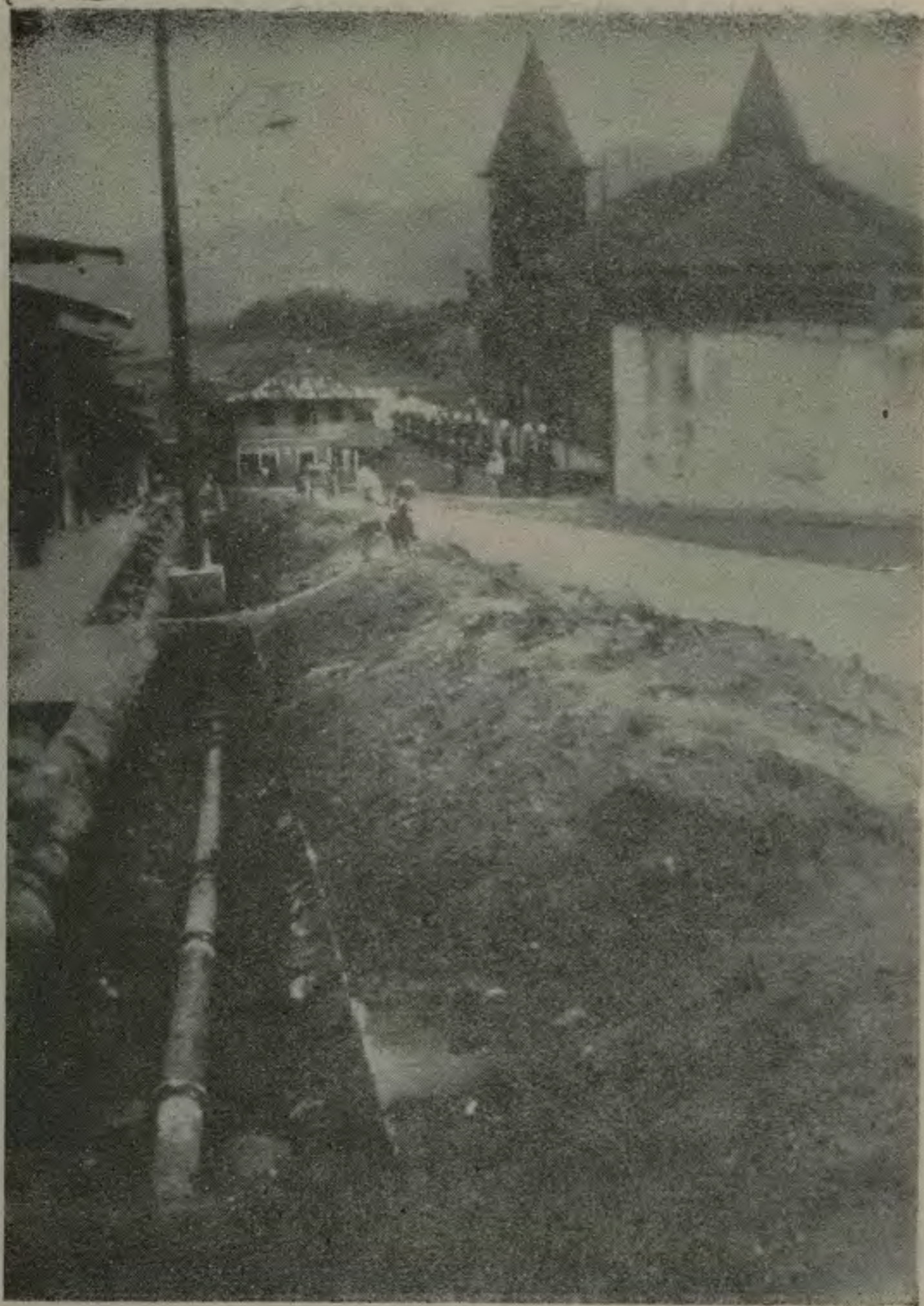
Trabajos en la cañería de Juan Viñas.
