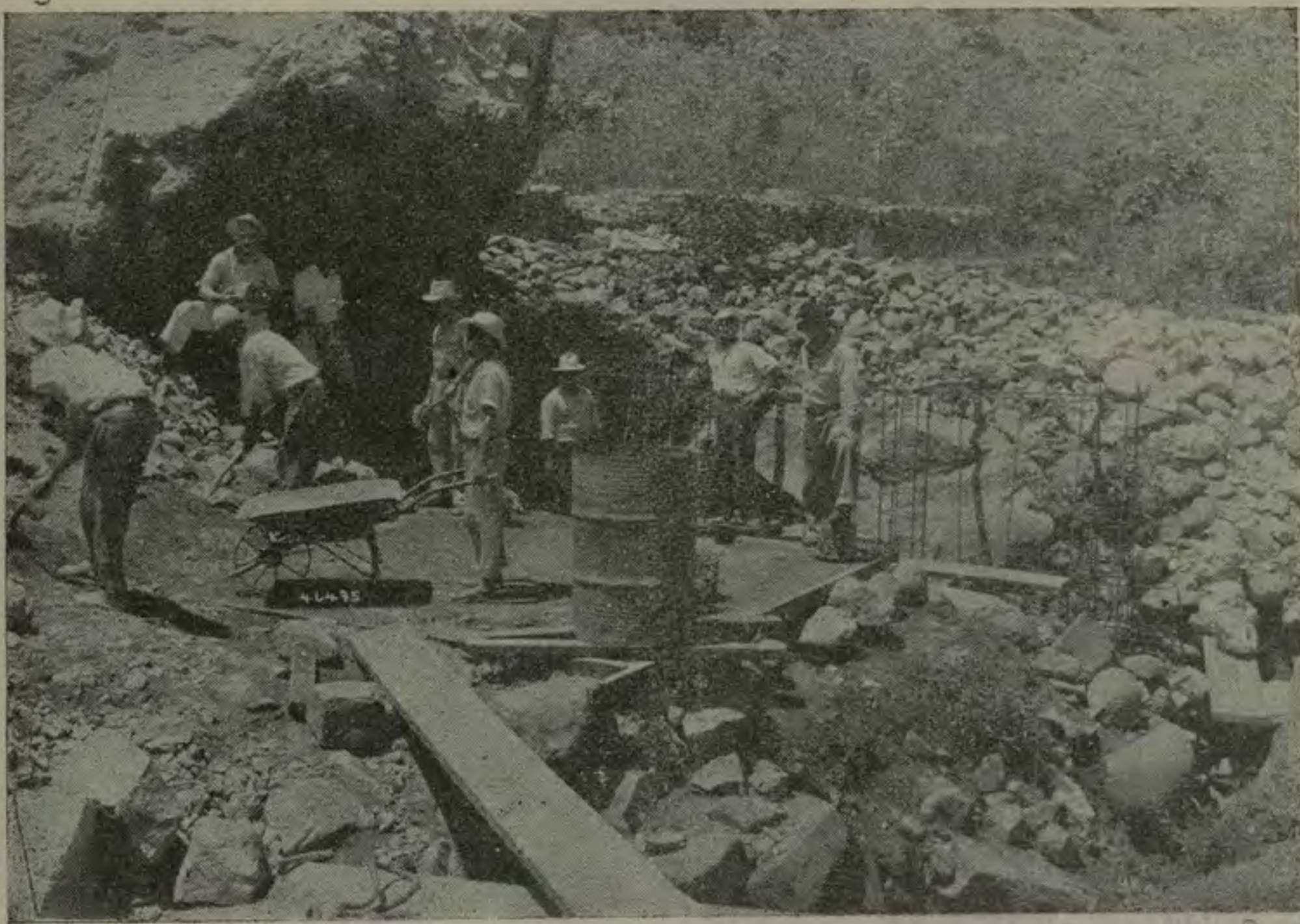
Construcción de estanques para la cañería de San Antonio de Escazú.
