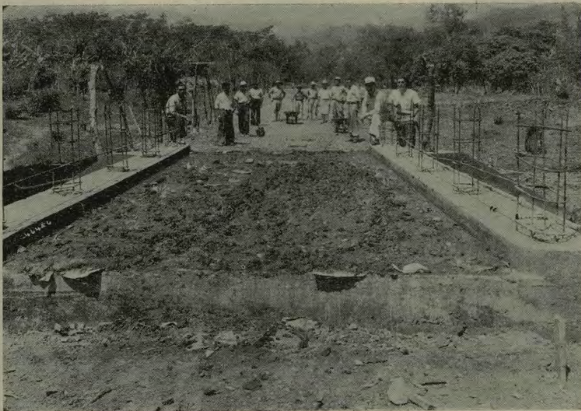
Puente en construcción sobre el río Guatuso en «El Llano» de Desamparados.
