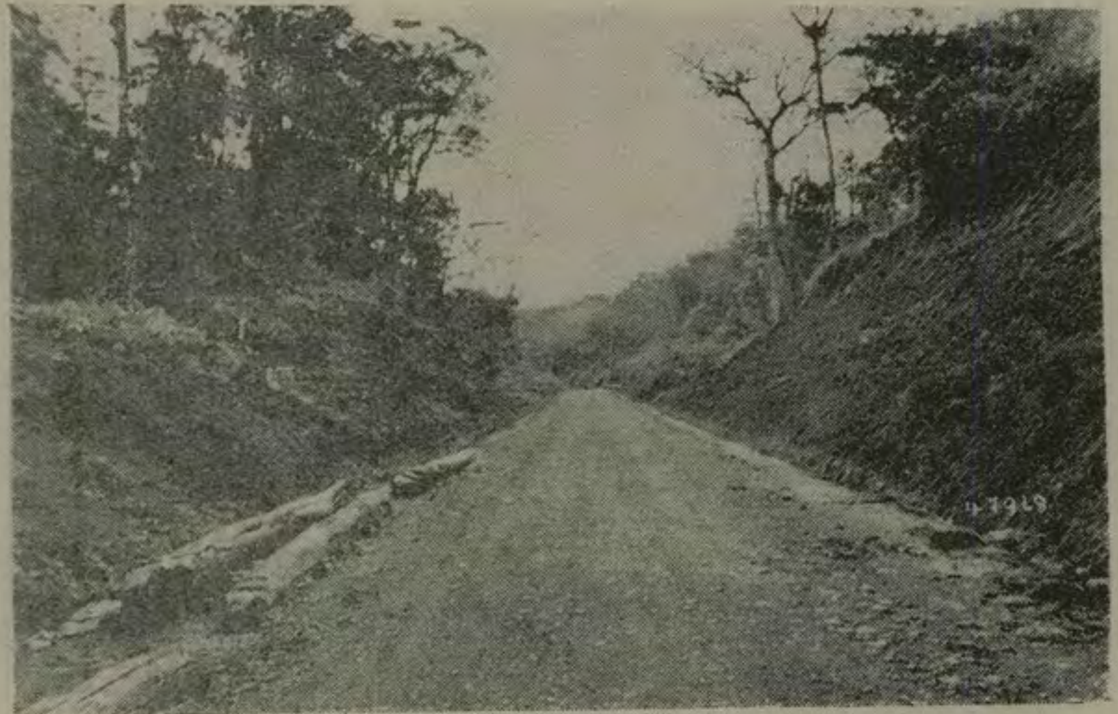
Carretera Villa Quesada - La Marina (cantón de San Carlos.)
