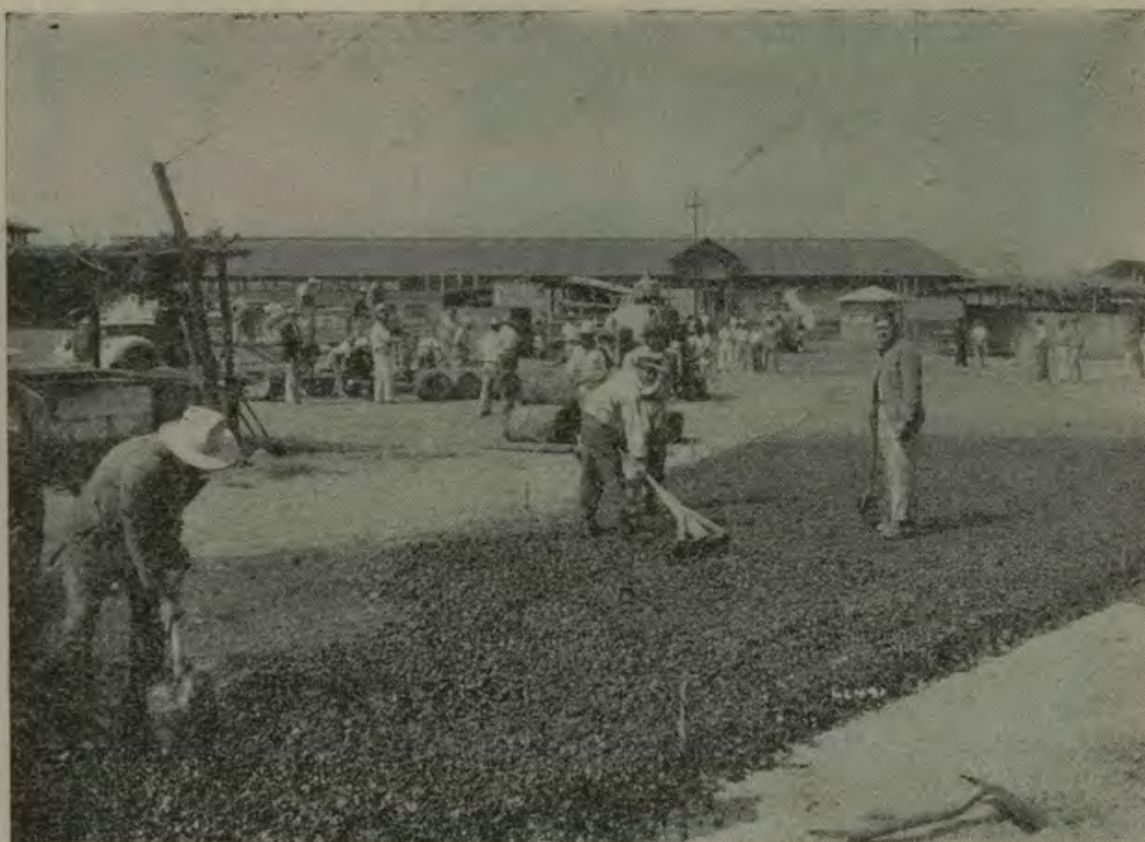
Trecho de carretera asfaltada en el Campo Ayala.
