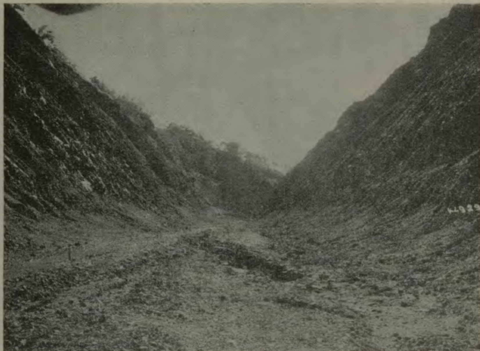
Cortes en la carretera en construcción Villa Colón- Puriscal.
