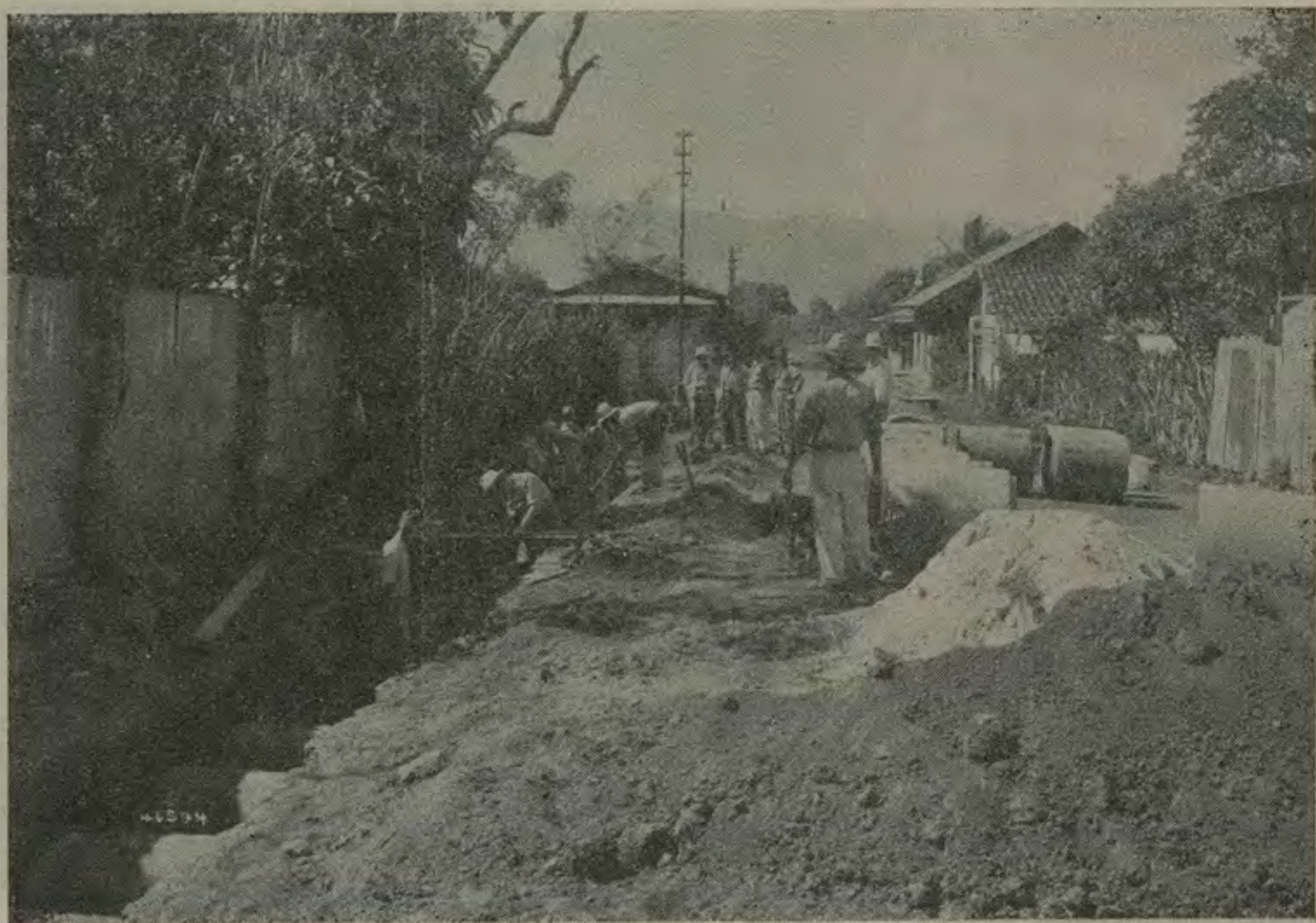
Ciudad de Alajuela. Trabajos de alcantarillado y caños.
