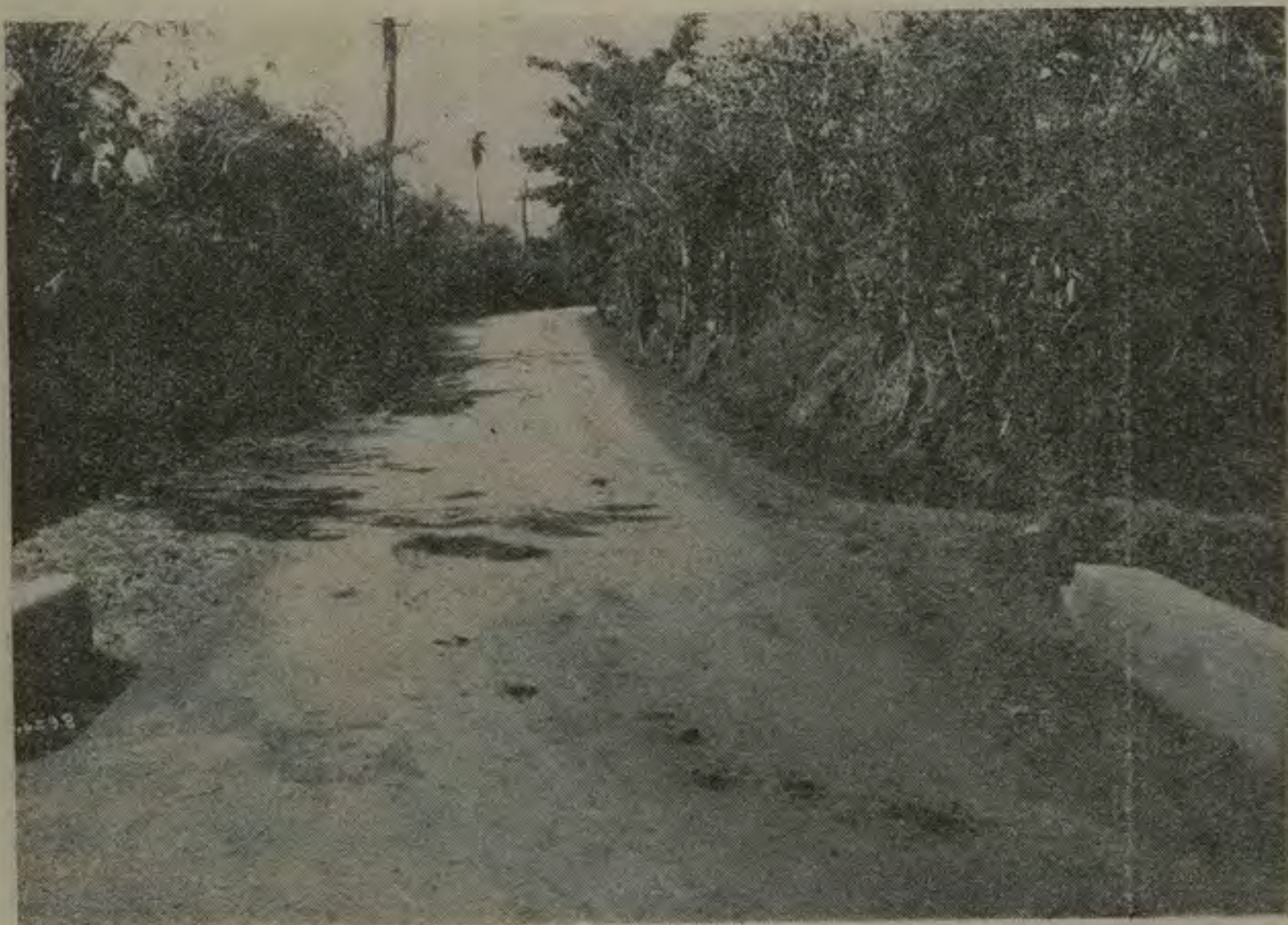
En la carretera de Alajuela a Coyoil hubo necesidad de construir una alcantarilla, indispensable para la conservación de la vía.
