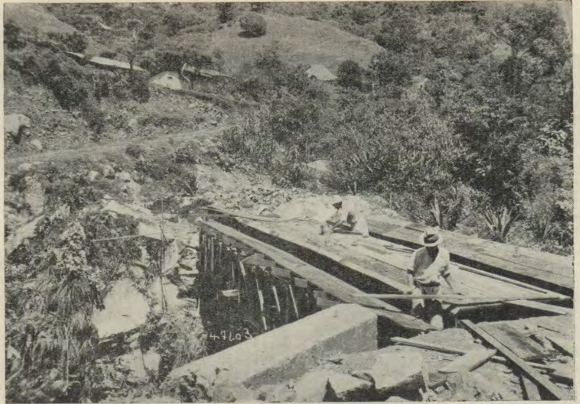
Puente en construcci3n en San Andr3s. (Tarraz3)
