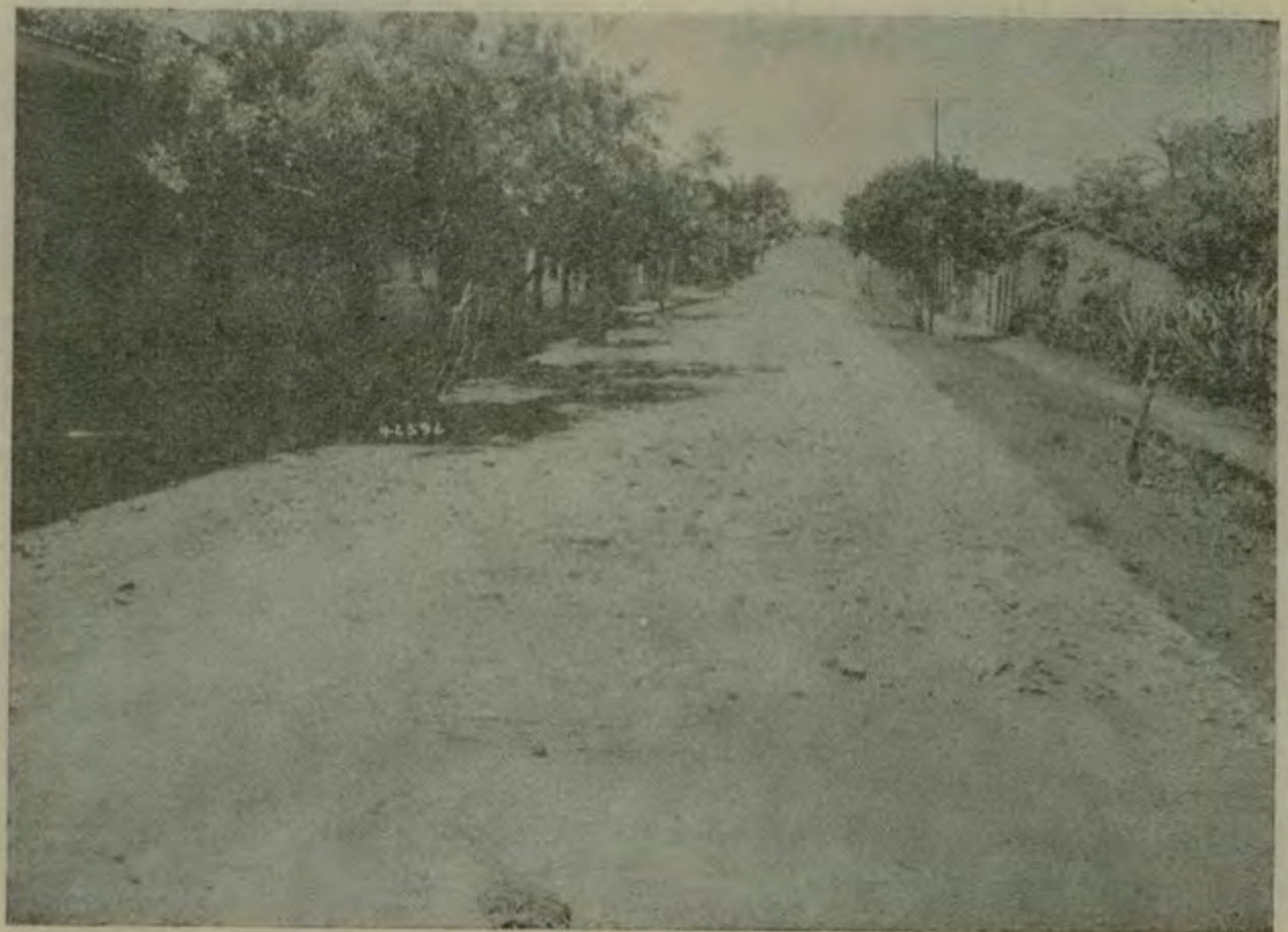
Cuenta ahora la ciudad de Naranjo con magníficas calles que realzan la belleza natural del lugar y la de los edificios que pregonan su progreso.
