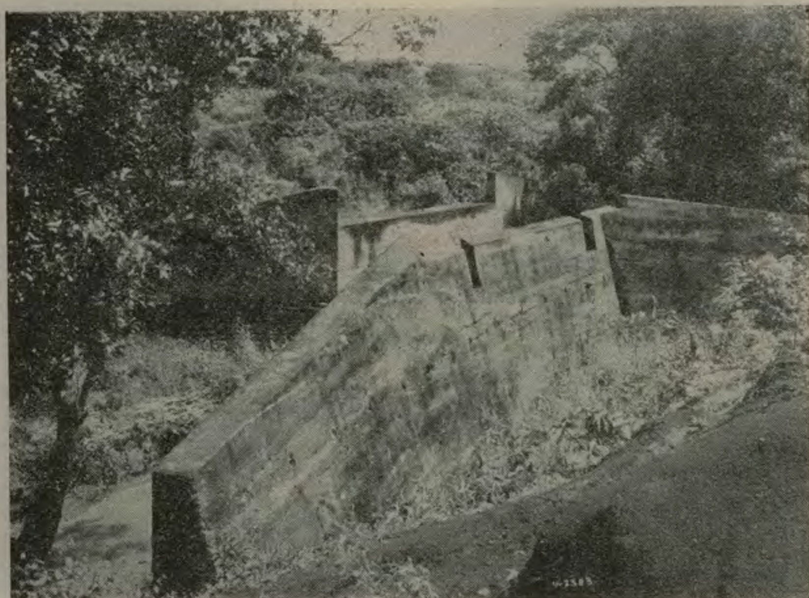
Cantón de Grecia. Puente en construcción sobre el río Tacares en la carretera «Pinto-La Argentina.»
