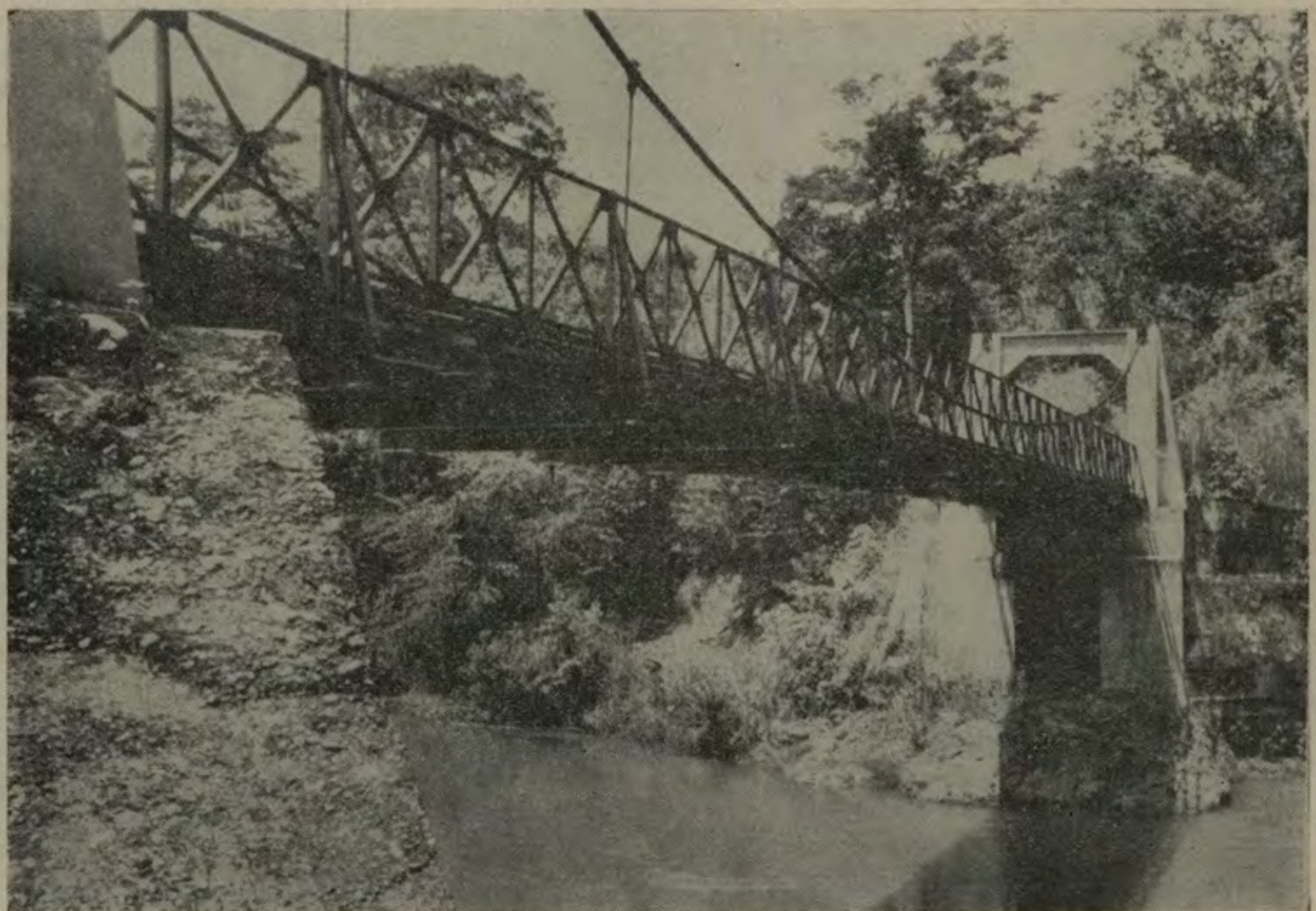
Puente reconstruido sobre el río «Molinillo» en el cantón de Orotina.
