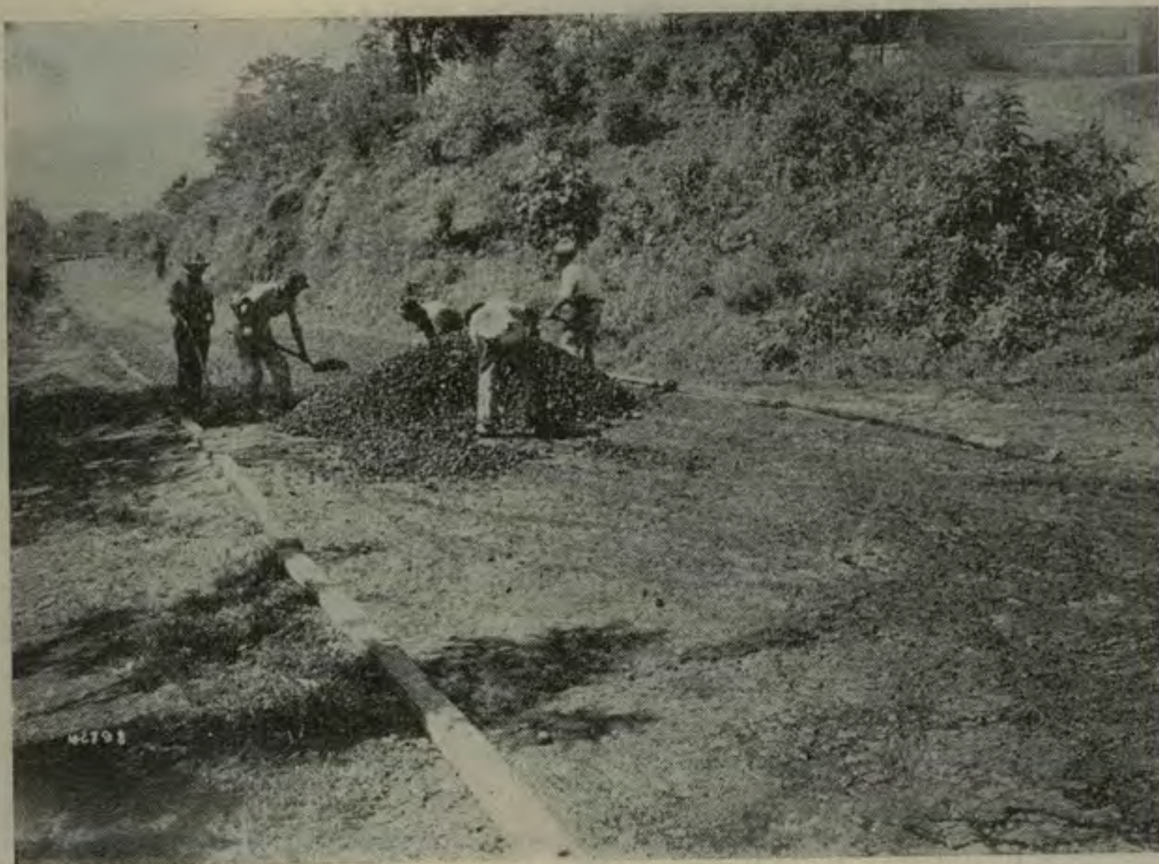
El grabado muestra los trabajos de asfaltado de la carretera Turrialba-Aquiáres.
