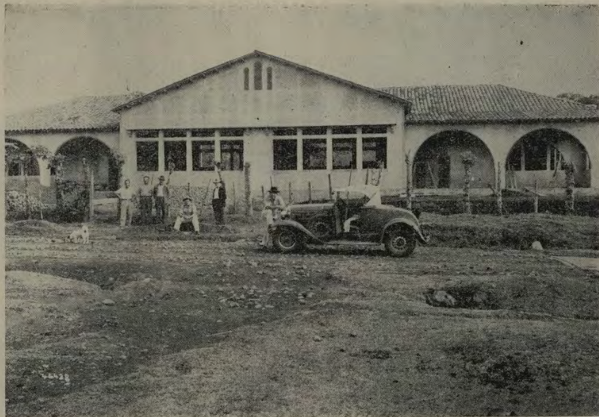
En Sabanilla de Montes de Oca se está construyendo actualmente este cómodo edificio escolar.
