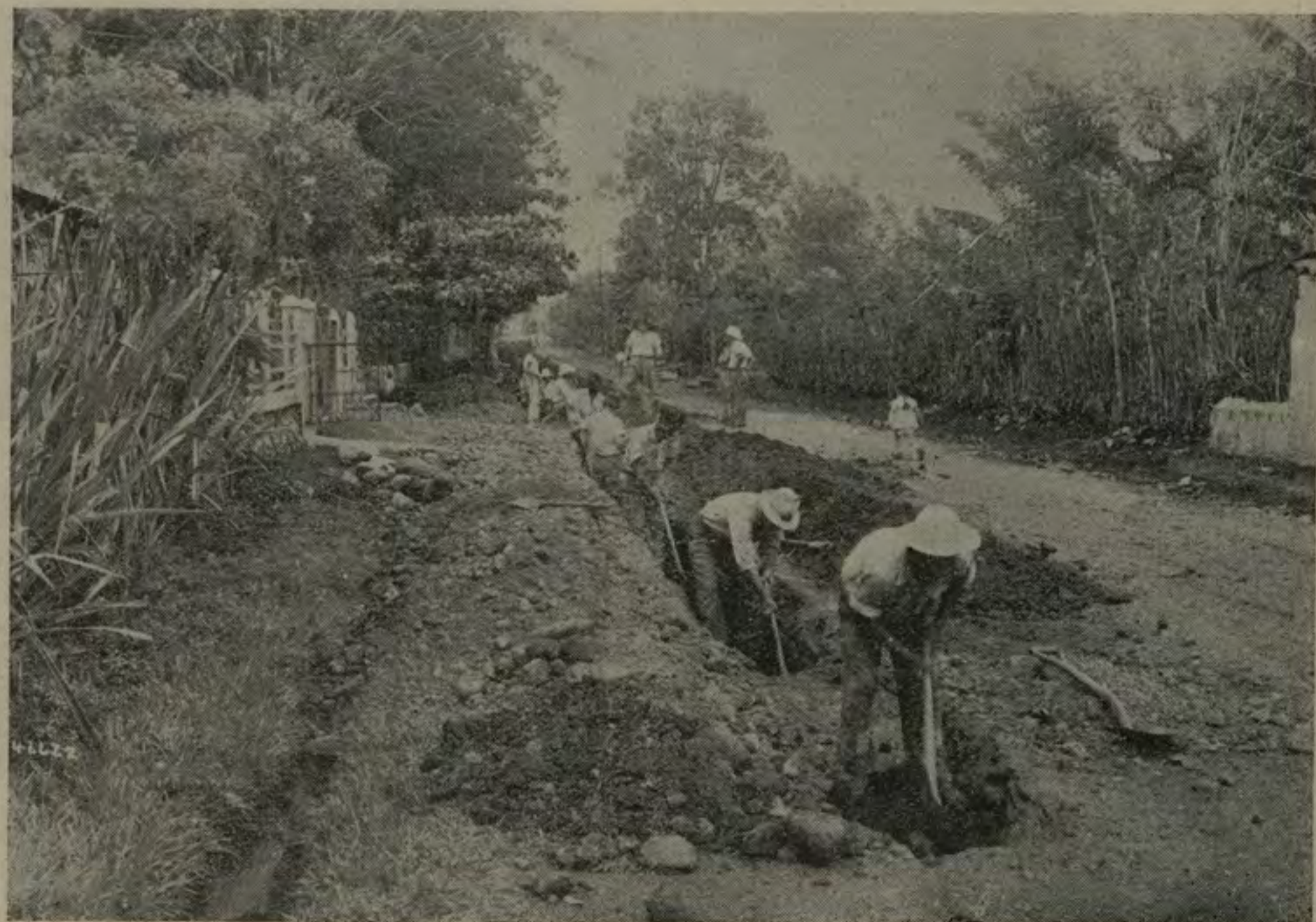
Ciudad de Alajuela. Trabajos en la cañería al Brazil.
