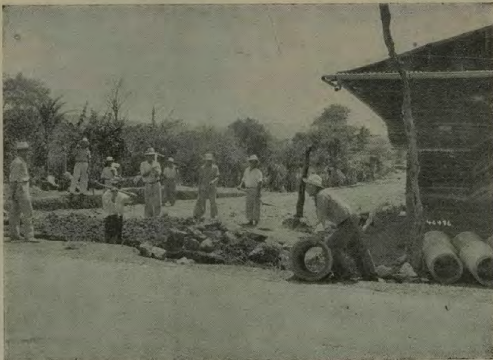
Arreglo de calles en Villa Colón.
