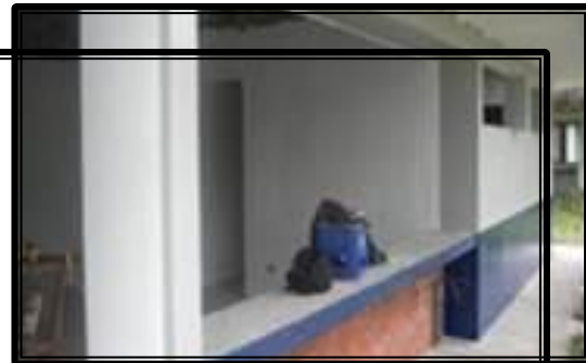
Cobertizo Montacargas Moín
