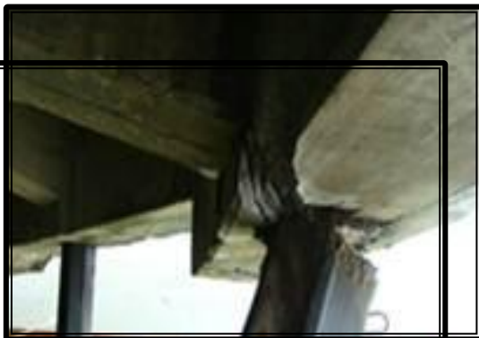
Reparación estructural Muelle Moín
