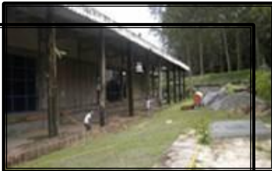
Cobertizo Montacargas Moín
