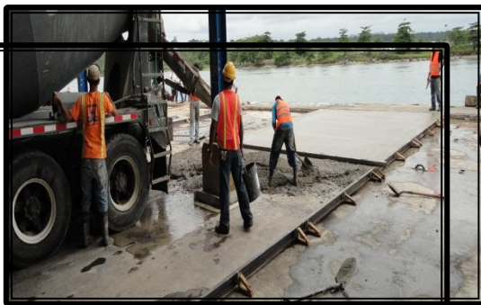
Reparaciones loza Moín
