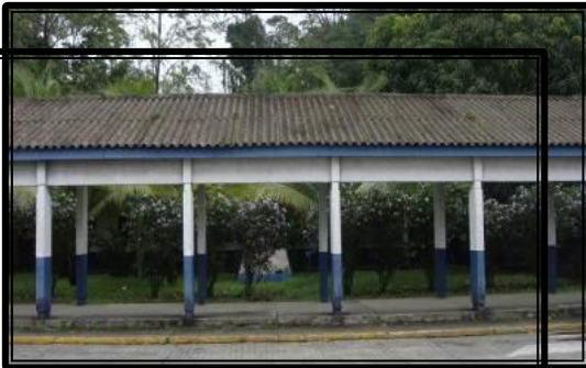
Cubierta Edif. Intendencia Moín
