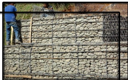
Muro de gaviones
