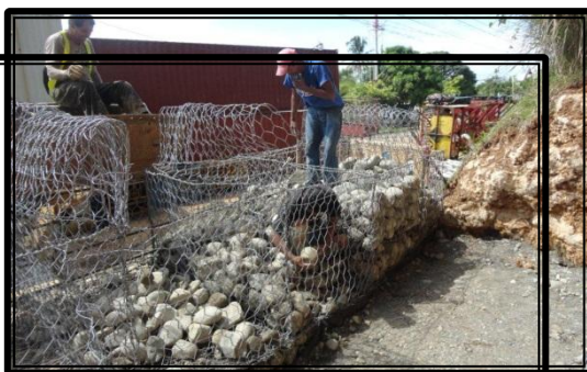
Muro de gaviones
