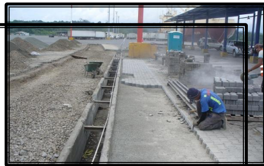
Reparación loza Moín
