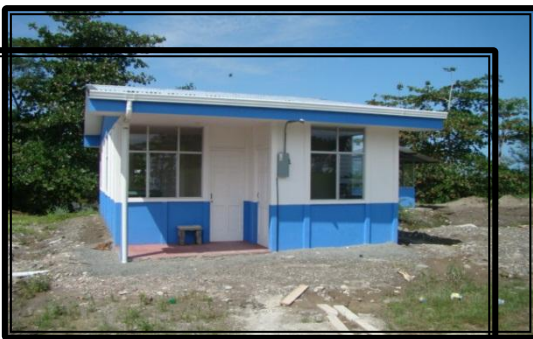
Construcción Unidad K9
