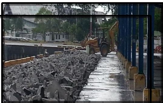
Reparación estructural muelle Moín
