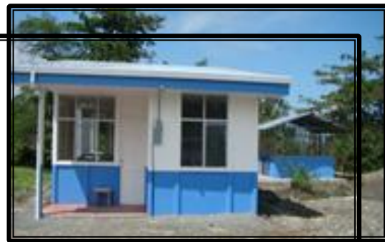
Construcción Unidad K9
