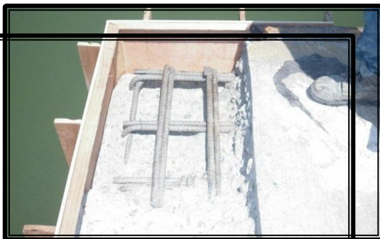
Reparación estructural muelle cruceros
