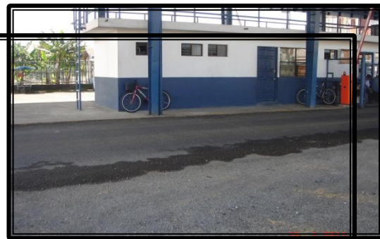
Reparaciones superficie de rodamiento Limón
