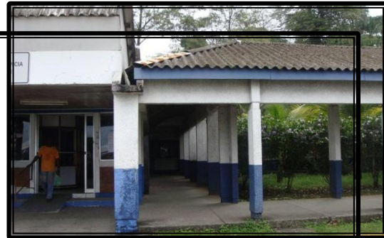
Cubierta Edif. Intendencia Moín
