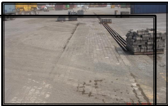
Reparaciones superficie de rodamiento Limón
