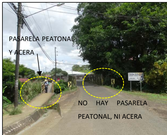
Figura N° 7. Puente angosto existente.
