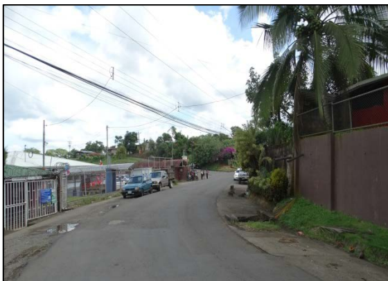
Figura N° 2. Frente al colegio con acera en mal estado
