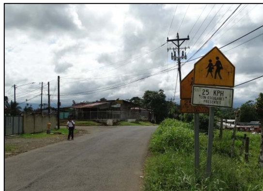
Figura N° 5. Señalamiento Vertical existente
