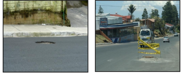
Figura 2.39 Caso especial, Alcantarillas Desniveladas
