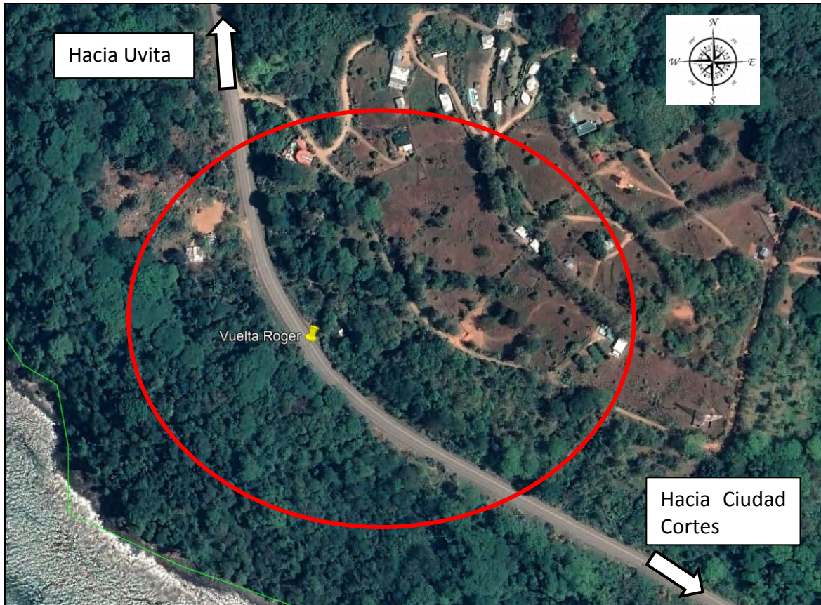
Imagen 1. Ubicación geográfica de la zona de estudio Vuelta de Don Roger, Ruta Nacional N° 34.
