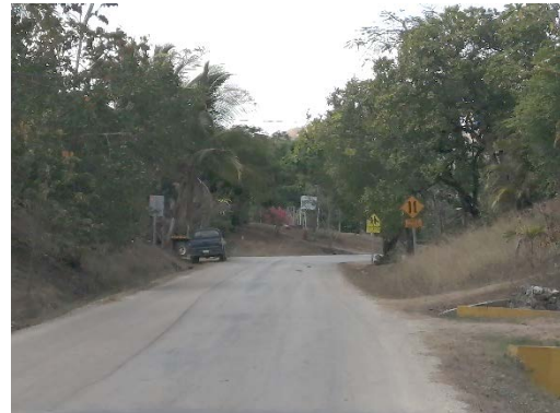
Figura N° 3. Ruta Nacional N° 163, sentido 2-1, San Blas - Jicaral
