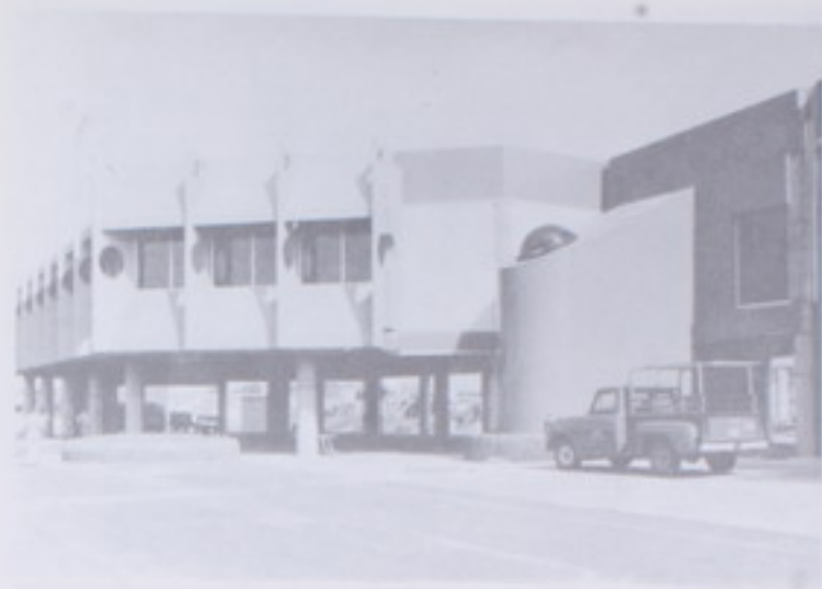
Vista parcial de las nuevas instalaciones construidas en el Aeropuerto Juan Santamaría.
