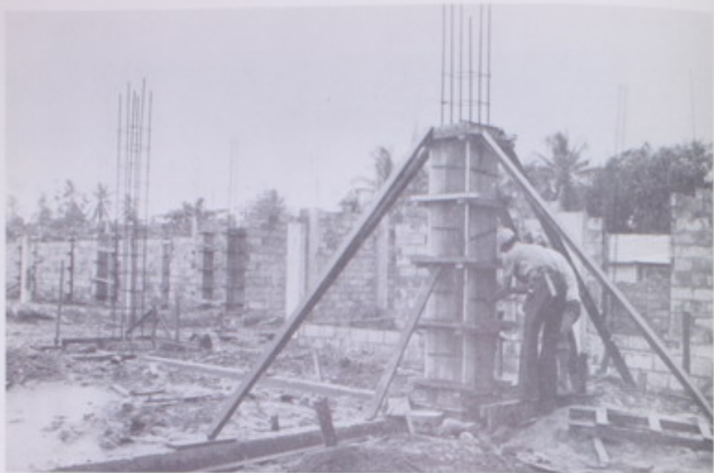
Construcción Escuela Nieworowsky.
