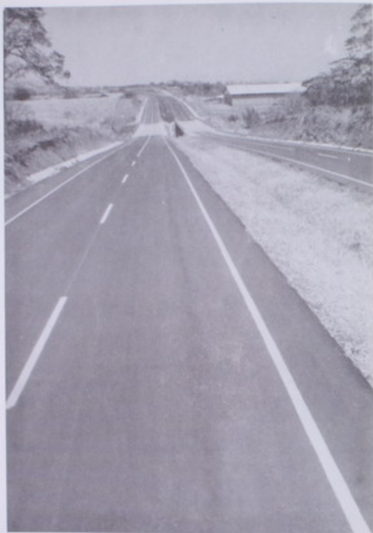
Autopista Escazú - Ciudad Colón.
