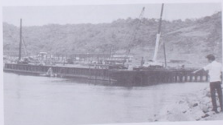
Obras en Caldera.
