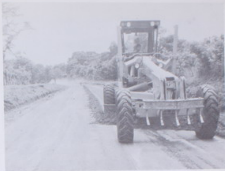
Muy adelantada construcción de la carretera Esparza - San Mateo.
