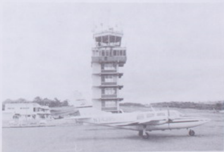
Torre de Control del Aeropuerto Tobías Bolaños de Pavas.
