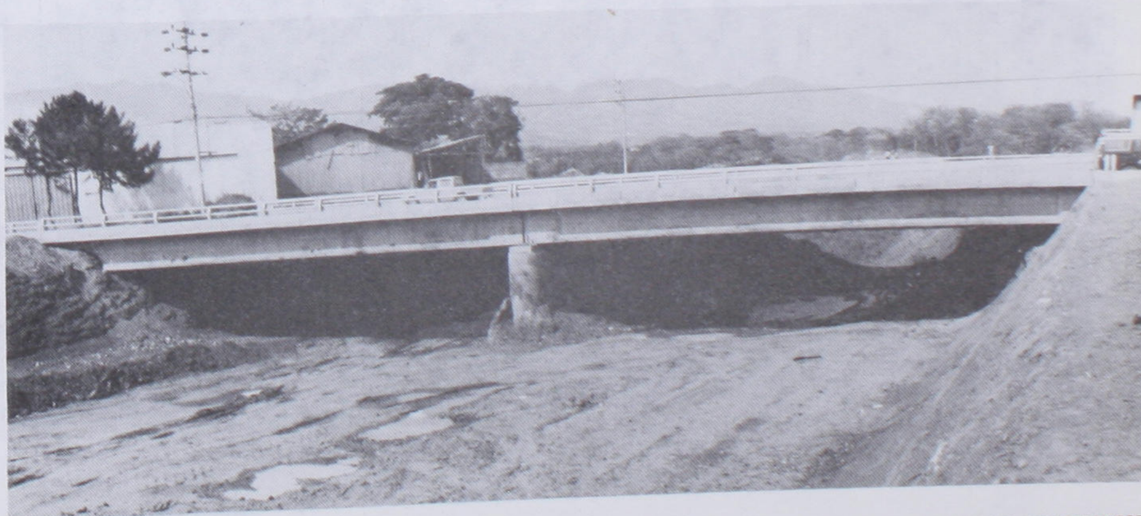
PUENTE RADIAL TOURNON RUTA 102 TIBAS
