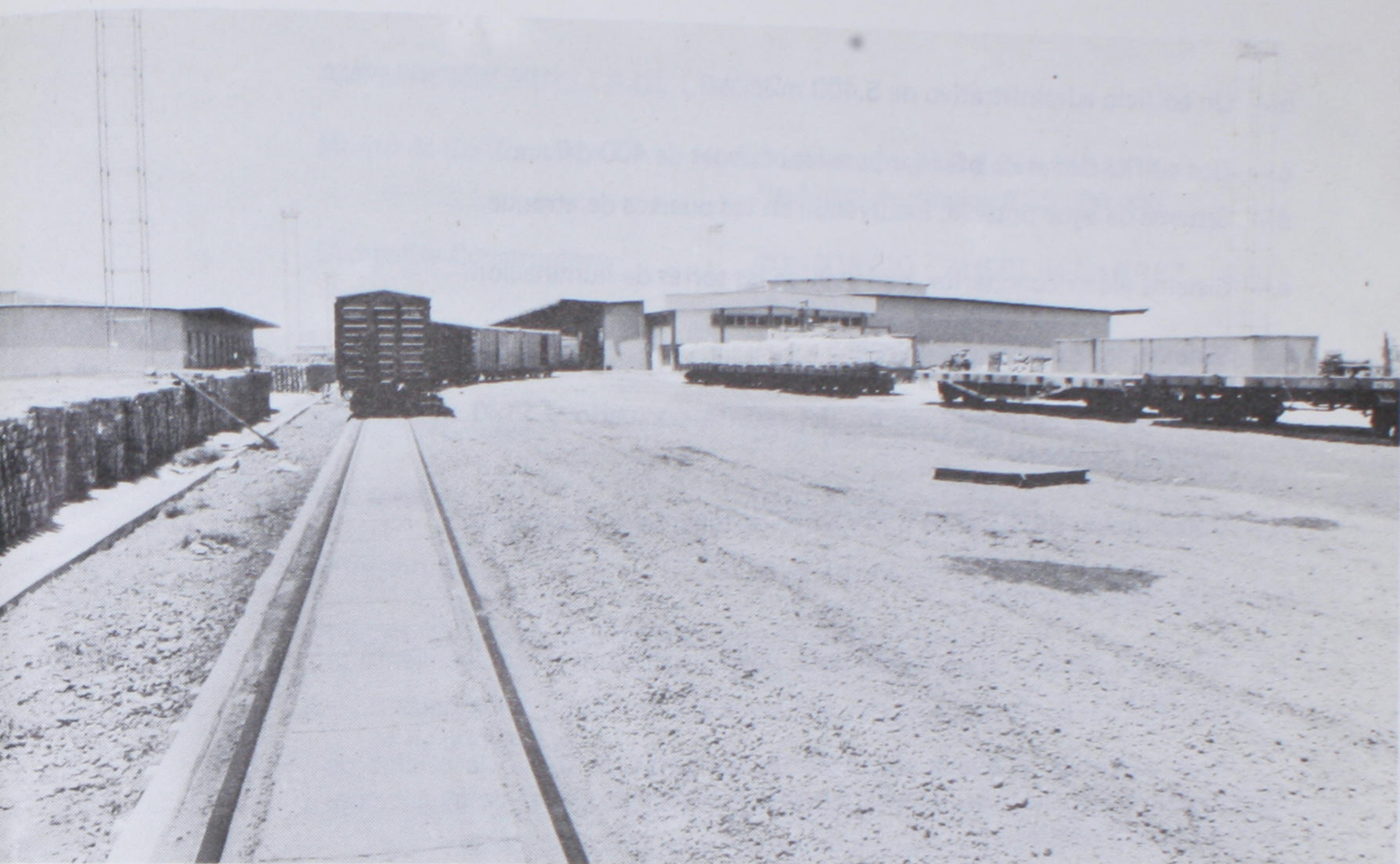
INSTALACIONES PROYECTO CALDERA
