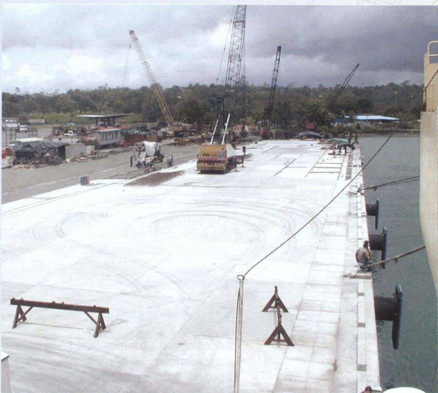
Ampliación del muelle de Moín.
