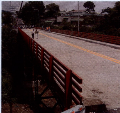
Ampliación de puente Los Anonos.
