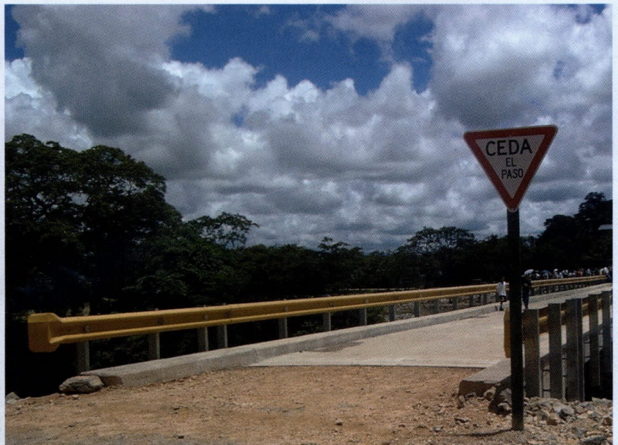
Puente Quebrada La Arena, Guanacaste.
