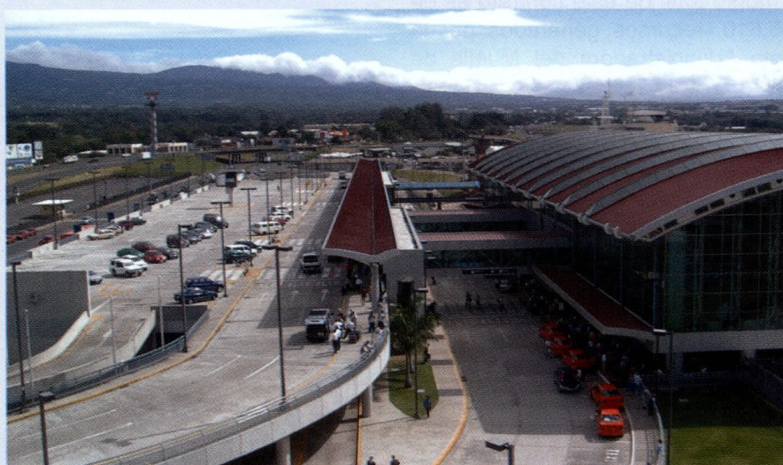
Nuevo edificio terminal Aeropuerto Internacional Juan Santamaría.
