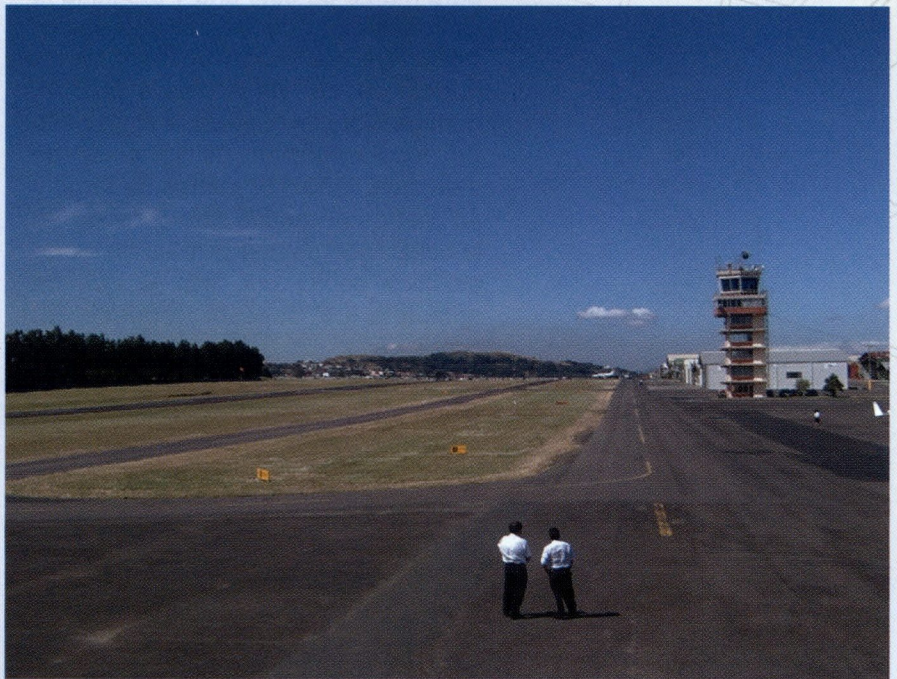
Ampliación pista Aeropuerto Tobías Bolaños.
