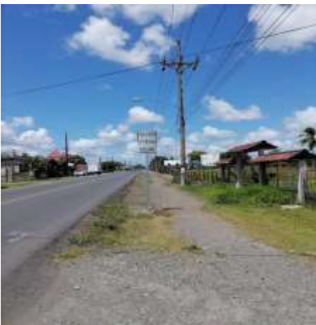
Figura 6. Señalización vial realizada acceso sur
