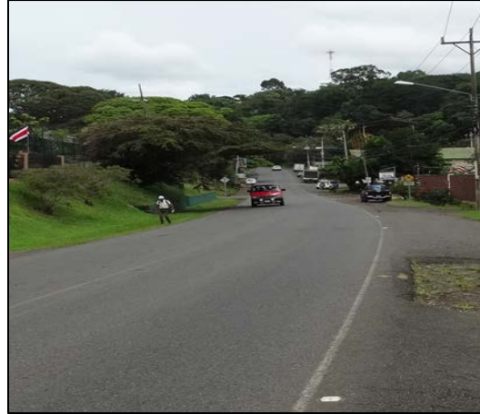
Figura N° 2. Asfalto sin grietas y baches
