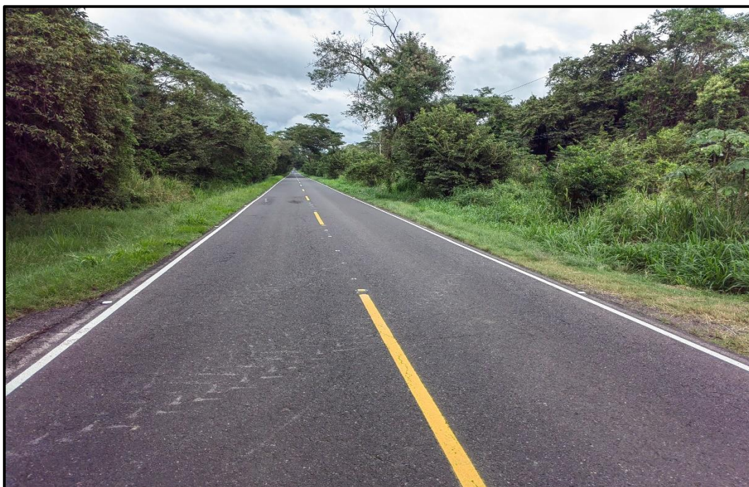
Imagen N° 13. Línea de centro intermitente y líneas de borde.
