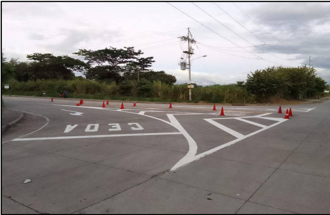
Imagen N° 8. Demarcación islas canalizadores, flechas direccionales y letreros.
