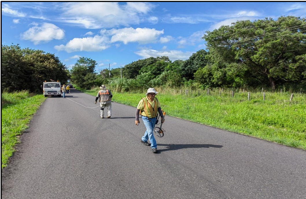
Imagen N° 3. Trabajos de punteo de línea de centro.
