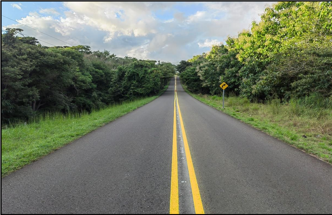
Imagen N° 5. Acabado línea continua de centro amarilla.
