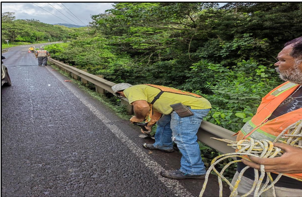
Imagen N° 11. Limpieza de puentes.
