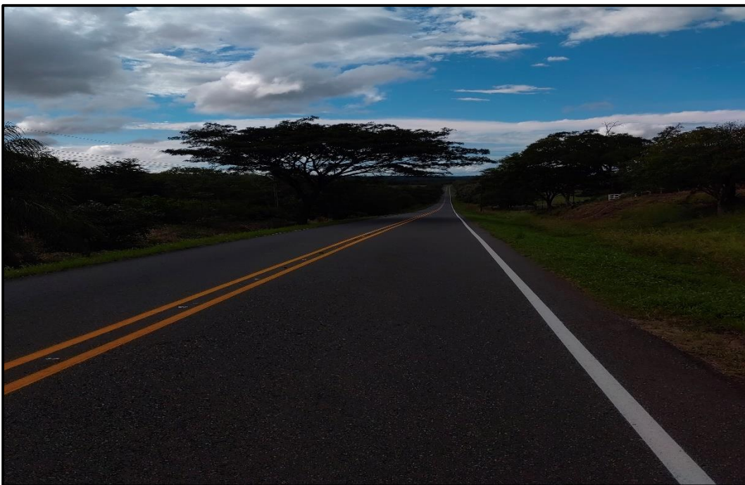
Imagen N° 7. Línea de borde continua blanca demarcada.
