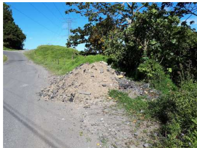
Fotografía 3: escombrera de material socavado.
