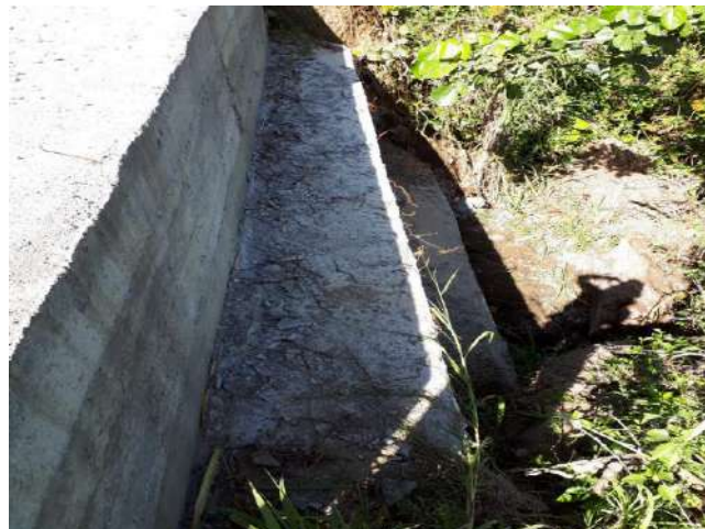
Fotografía 2: nuevo muro de contención.
