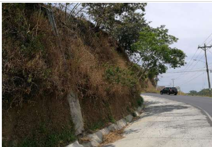
Fotografía 5: cordón de caño existente y cuneta.
