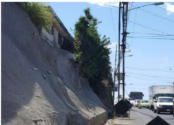
Fotografía 1: vista parcial de las intervenciones realizadas.
