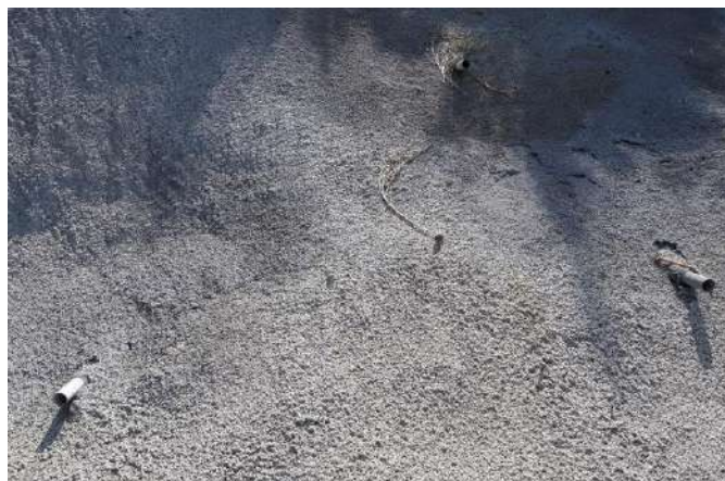
Fotografía 4: tubería para la extracción del agua del talud.
