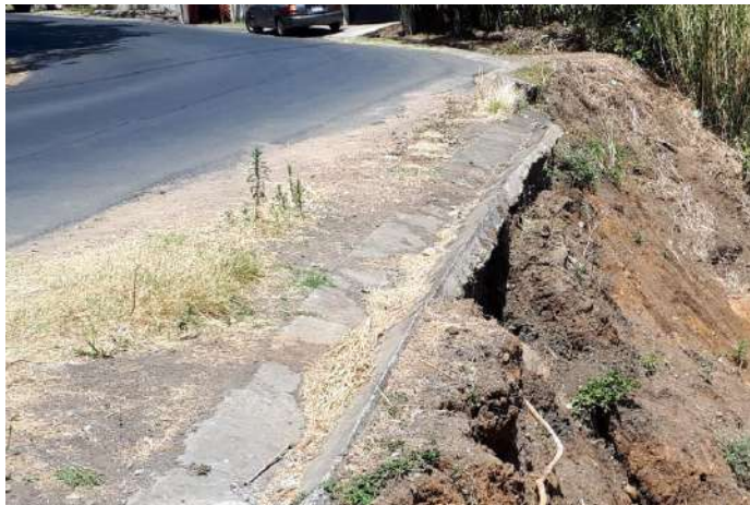
Fotografía 2: vista lateral del cordón de caño.
