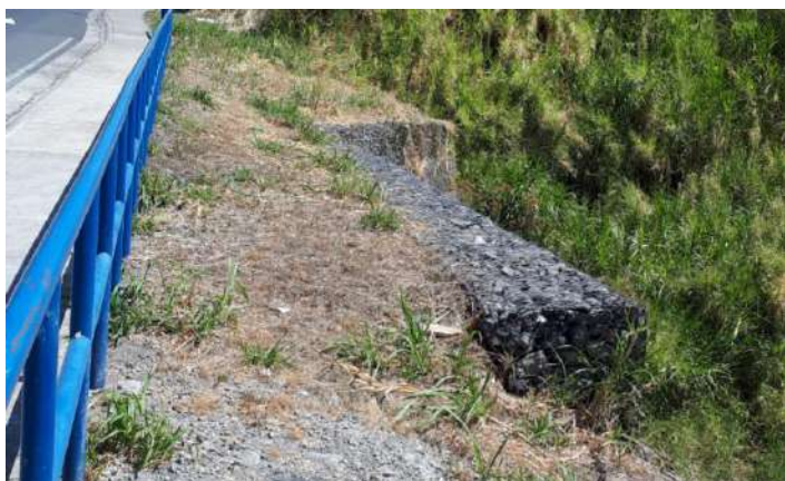
Fotografía 1: muro de gaviones.
