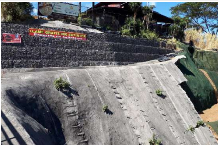
Fotografía 3: muro de gaviones sobre el talud.
