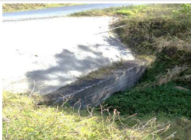
Fotografía 5: vista parcial de alcantarilla.
