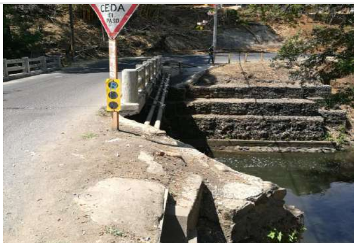
Fotografía 5: muro de gaviones en ambas márgenes del río.
