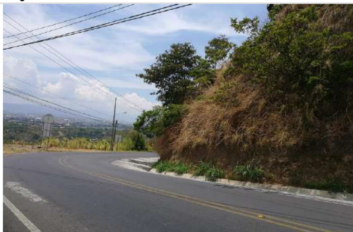
Fotografía 1: vista parcial del talud.
