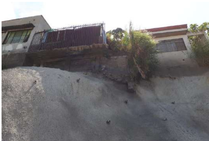
Fotografía 2: viviendas en la parte alta del talud.
