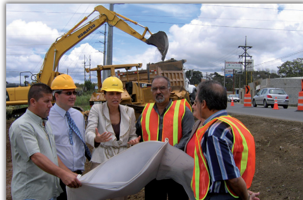
Inicio de Obras en Cartago-Paraíso.
