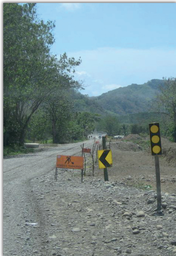
Construcción de tramo Savegre-Barú.
