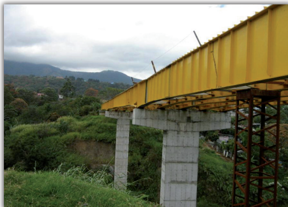
Puente río Tiribí, Radial alterna a Escazú.
