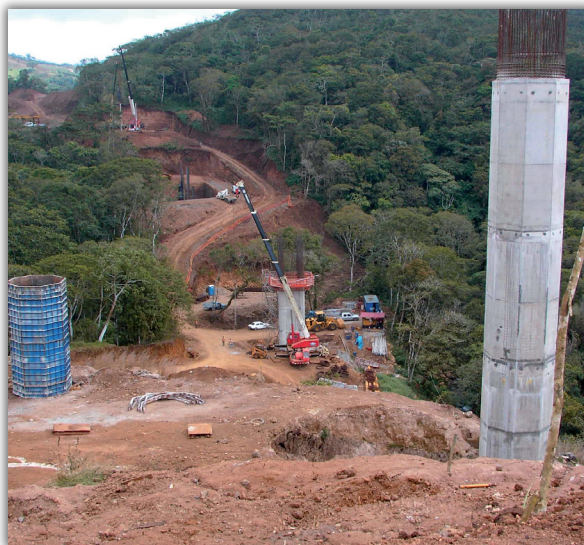
Construcción de pilas Puente Barranca.
