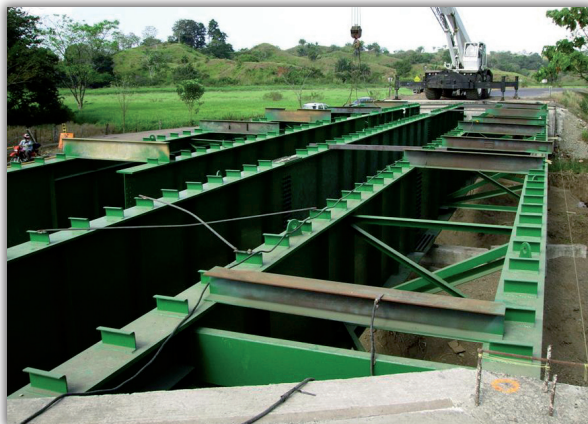
Construcción de Puente río Las Vueltas, Parrita-Quepos.
