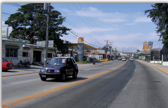
Ampliación en concreto a cuatro carriles El Alto de Guadalupe.
