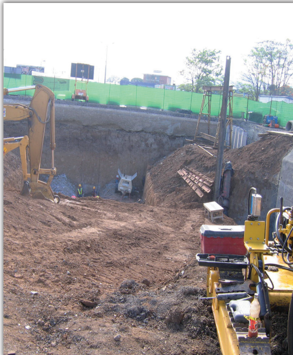
Excavaciones núcleo de Rotonda San Sebastian.
