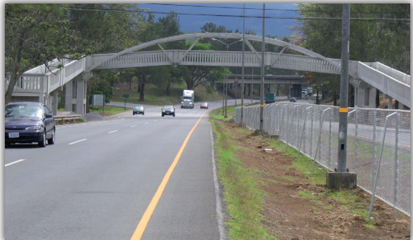
Puente Peatonal Hacienda Vieja-Curridabat.
