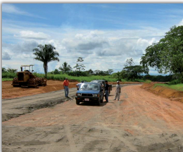
Construcción de nueva carretera Los Chiles-Las Tablitas.
