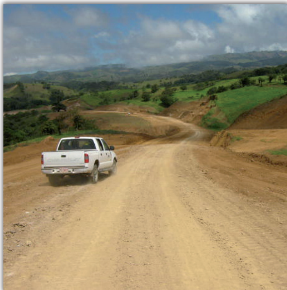
Construcción de Carretera Sección Alto Villegas.
