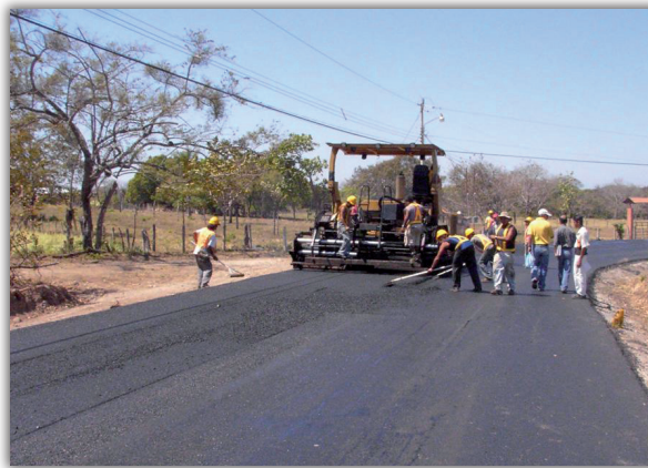
Asfaltado del tramo Interamericana-Guacimal.
