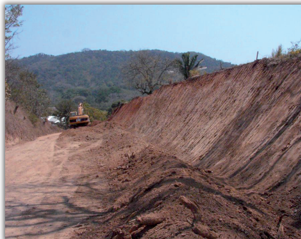
Obras de mejoramiento en ejecución, Puerto-Carrillo-Estrada-Lajas
