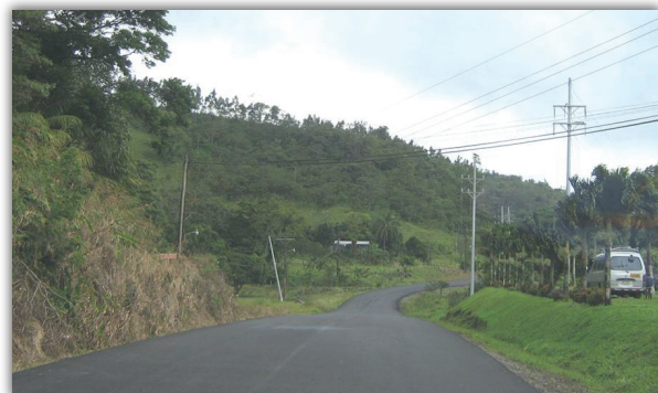
Rehabilitación de la ruta, Cruce Río Tenorio-Upala.
