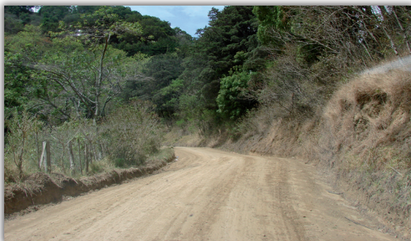
Relastrado Higuito - Copalchí.
