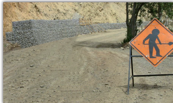
Mejoramiento de la ruta, Palmichal-Chirracá.
