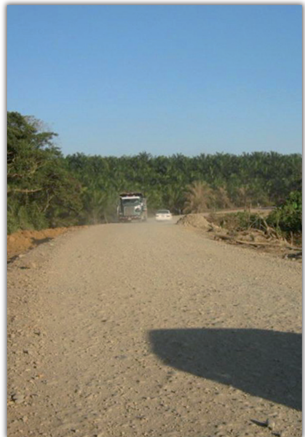
Construcción de tramo Quepos-Savegre.
