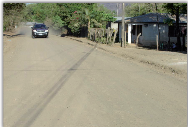
Camino Santa Cruz- Los Ranchos, intervención en lastre.
