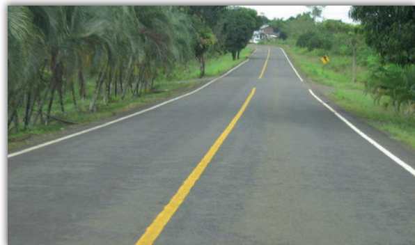
Rehabilitación de la ruta ya concluida, San Rafael de Guatuso-San José de Upala.
