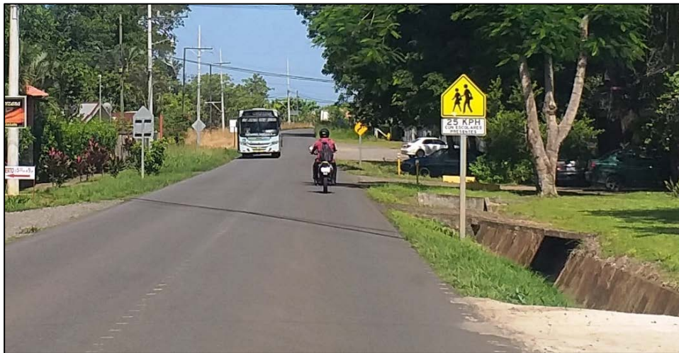
Figura 11. Señalamiento escolar incompleto
