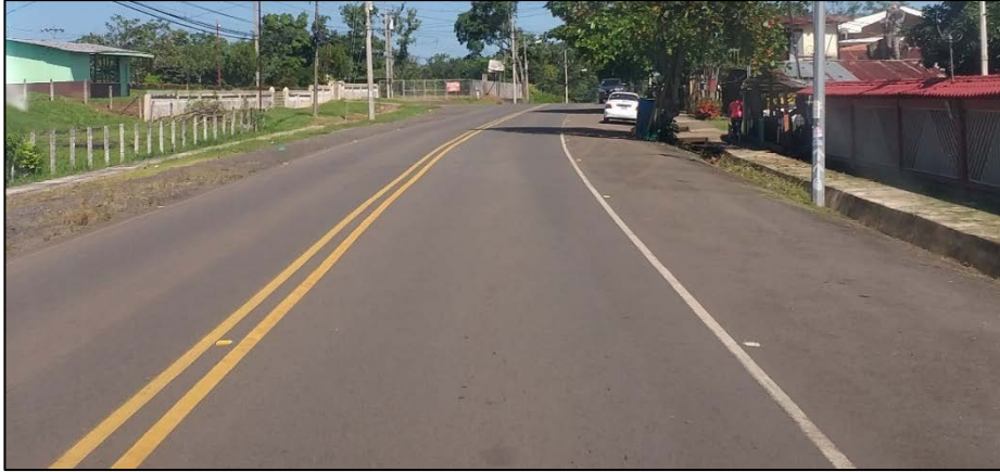
Figura 7. Líneas visibles y presencia de captaluces en algunos sectores
