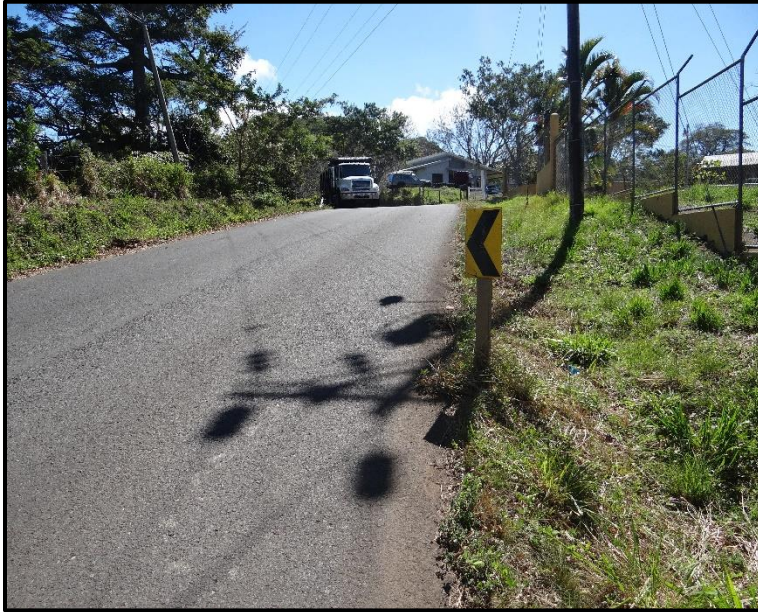
Imagen N° 4. Falta de acera.
