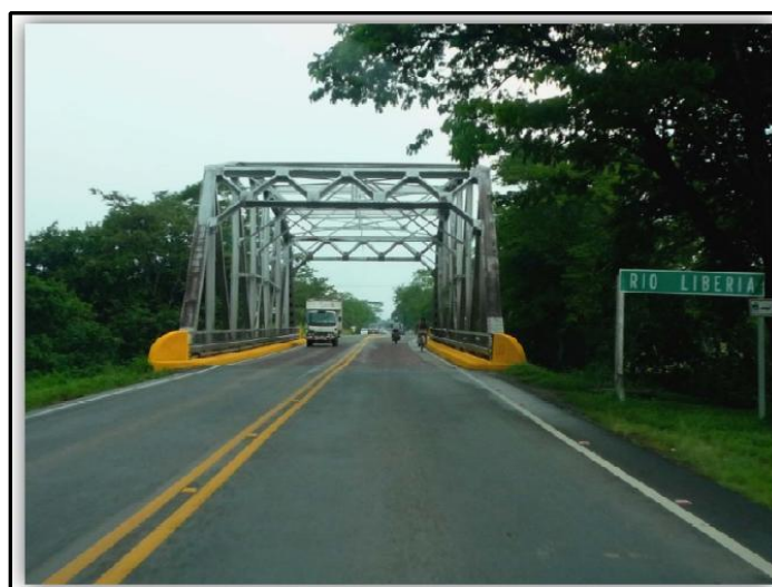
Fotografía N° 3.2. Puente sobre el Río Liberia
