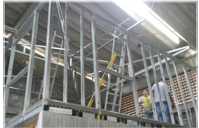
Taller mantenimiento muelles
