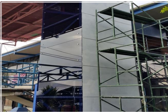
Elevador Edif. Multiuso
