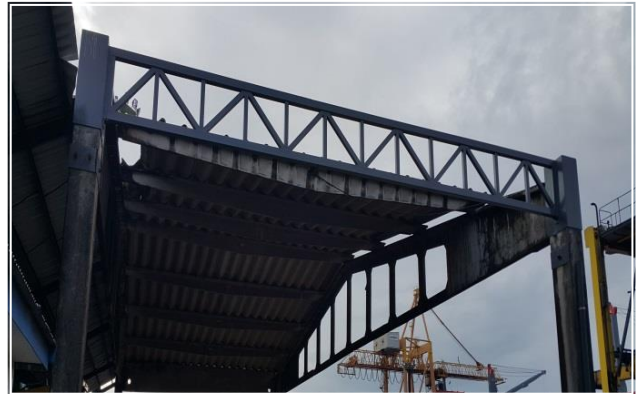
Viga Estructura techo montacargas
