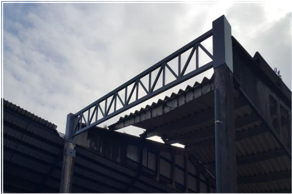
Viga Estructura techo montacargas
