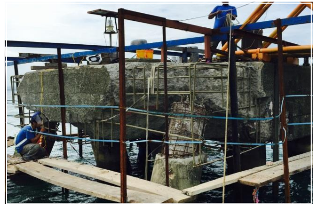
Reparación Duque Alba
