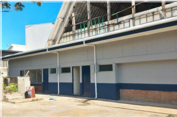
Taller mecánico Moín II Etapa
