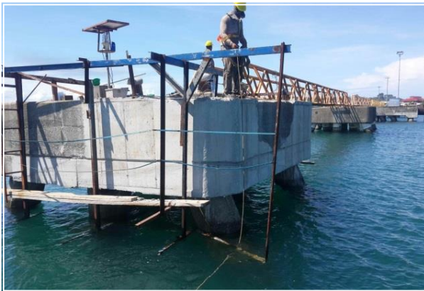
Reparación Duque Alba
