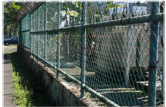
Cierre perimetral perimetro portuario
