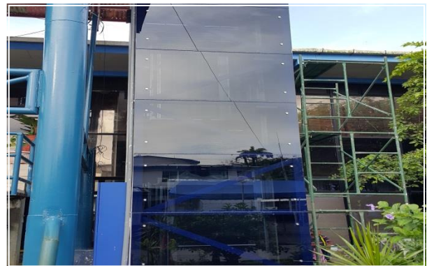
Elevador Edif. Multiuso
