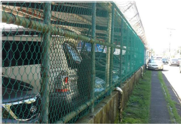
Cierre perimetral perimetro portuario
