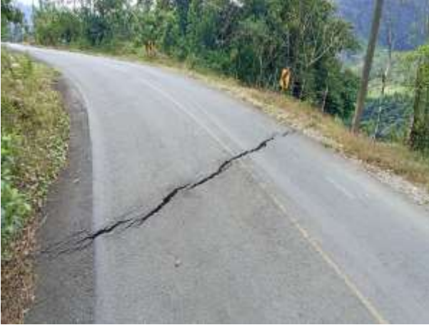
Figura 3. Agrietamientos horizontales
