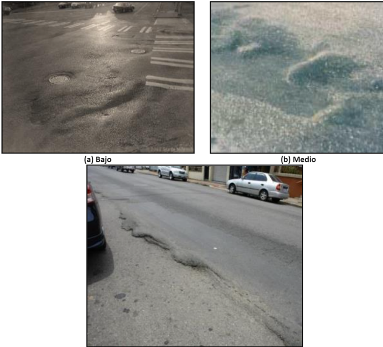
Figura 4.27 Imágenes de los niveles de severidad asociados a Corrimiento
