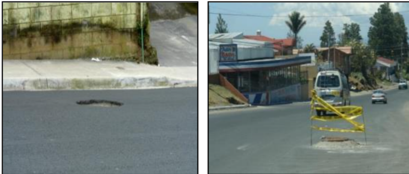
Figura 4.39 Caso especial, Alcantarillas Desniveladas
