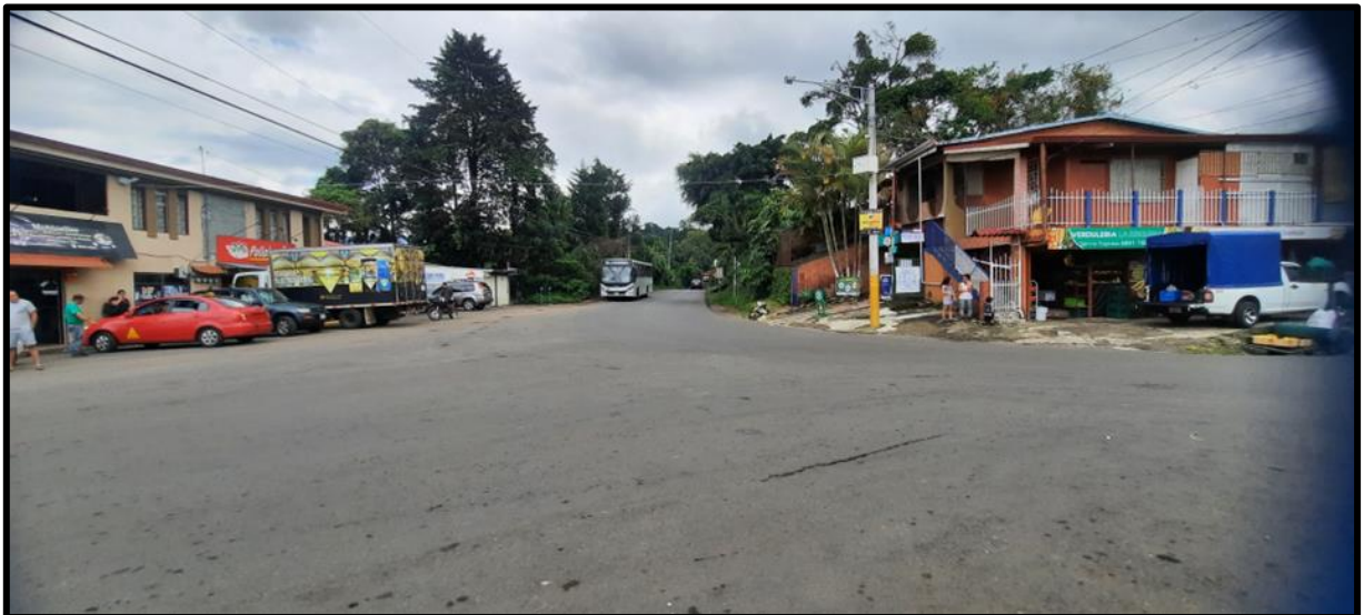
Figura 4 Vista norte intersección ruta nacional N.º 125 – ruta nacional N.º 126, Carrizal, Alajuela. Fuente: Propia.
